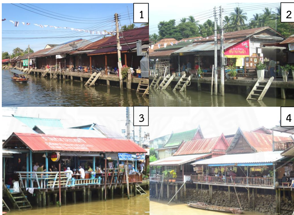
ภาพที่ 4.31 ลักษณะของเรือนแถวไม้ริมน้ำในพื้นที่คลองอัมพวา เรือนแถวไม้หลังคาทรงปั้นหยา (1) เรือนแถวไม้หลังคาทรงจั่วเดี่ยว (2) เรือนแถวไม้หลังคาทรงจั่วแฝด (3) และเรือนแถวไม้หลังคาทรงจั่วแฝดทรงไทย. โดย ผู้วิจัย, ภาพถ่าย ณ วันที่ 4 สิงหาคม 2556.
