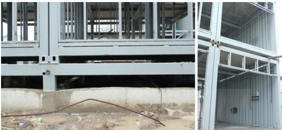
ภาพที่ 2.43 ฐานรากและผนังโครงคร่าวเหล็ก โครงการเดอะบ็อกซ์เรสซิเดนซ์ เฟสสอง. จาก ผู้วิจัย, 2555.
