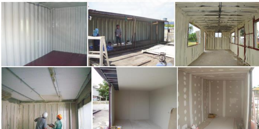
ภาพที่ 2.27 กระบวนการในการตัดแปลงตู้ขนส่งสินค้าที่มา. จาก บริษัท NGDREI, 2012.
