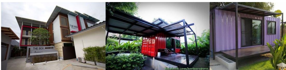
ภาพที่ 2.14 การใช้ตู้ขนส่งสินค้าตัดแปลงเป็นที่พักอาศัย. จาก ผู้วิจัย, 2556.
