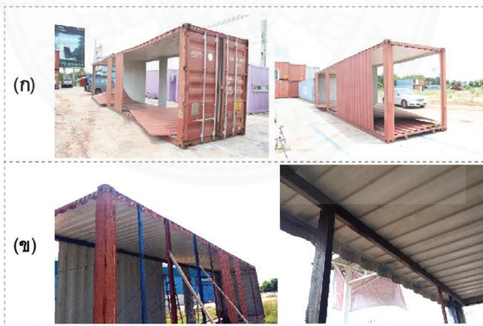
ภาพที่ 4.21 กระบวนการดัดแปลงตู้ขนส่งสินค้า. จาก ผู้วิจัย, 2557.
