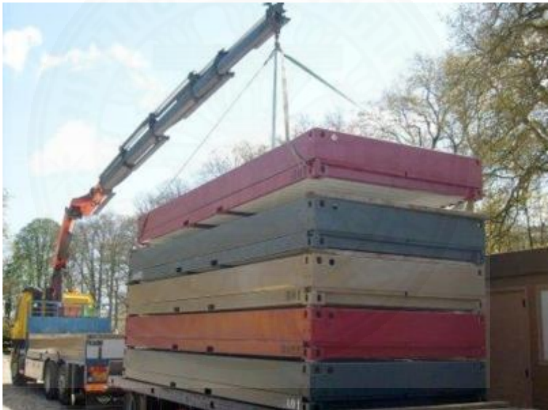
ภาพที่ 2.55 การใช้เครนขนาดเล็กและซ้อนชั้นหลายยูนิต. จาก flexotel, 2012.
