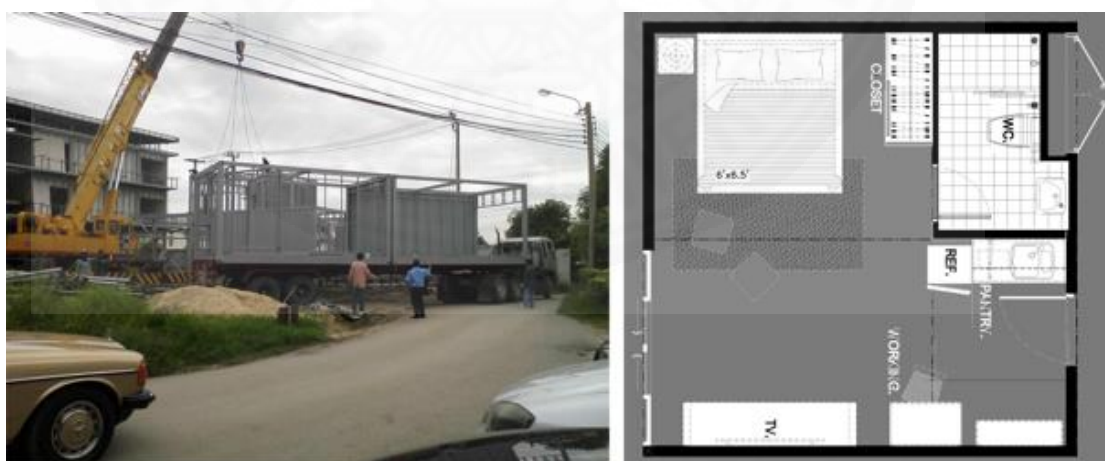
ภาพที่ 2.42 การติดตั้งและฝังพื้นห้องพัก โครงการเดอะบ็อกซ์เรสซิเดนซ์. เฟสสอง จาก เดอะบ็อกซ์เรสซิเดนซ์, 2555.
