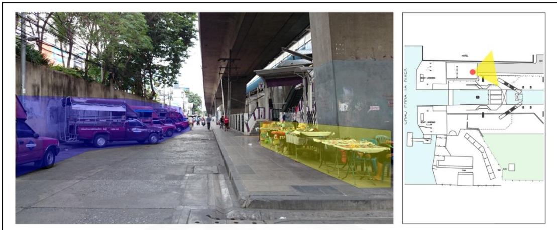
ภาพที่ 4.28 ร้านค้าแผงลอยด้านหน้าทางขึ้น-ลงสถานีรถไฟฟ้า
