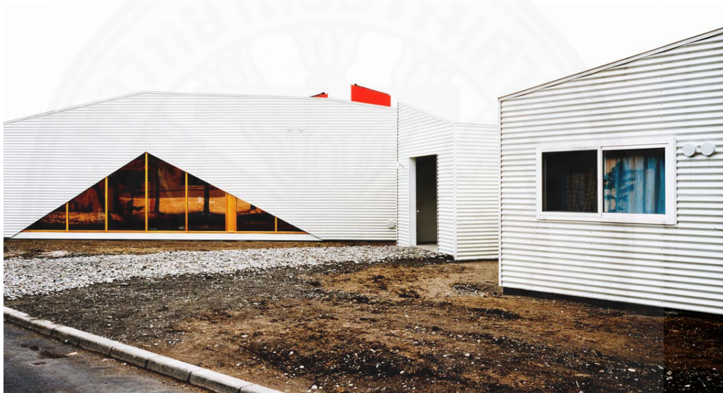
ภาพที่ 2.34 บริเวณโครงการ Group Home in Noboribetsu ประเทศญี่ปุ่น, โดย archdaily, 2014.
