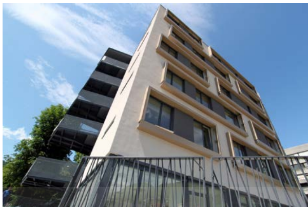
ภาพที่ 2.23 บริเวณ Facade ของโครงการ Home for the Elderly (Ravnika Potokar Arhitekturni), โดย archdaily, 2014.
