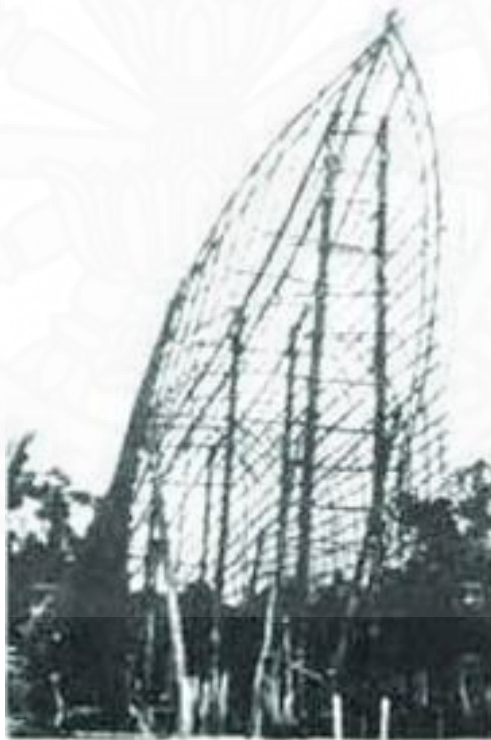
ภาพที่ 2.6 โครงสร้างไม้ไผ่ของบ้านพื้นเมืองและโครงสร้างไม้ไผ่ Meeting house in Maipua. จาก ไม้ไผ่กับสถาปัตยกรรมที่เลือนหาย โดย กานต์ คำแก้ว, 2546
