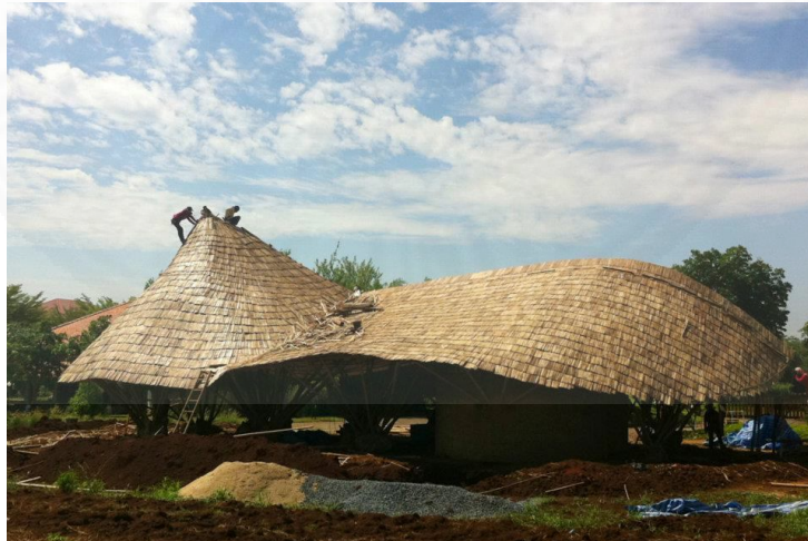
ภาพที่ 2.6 การมุงหลังคาอาคาร หมายเหตุ. Chiangmai Life Construction (CLC), 2555.
