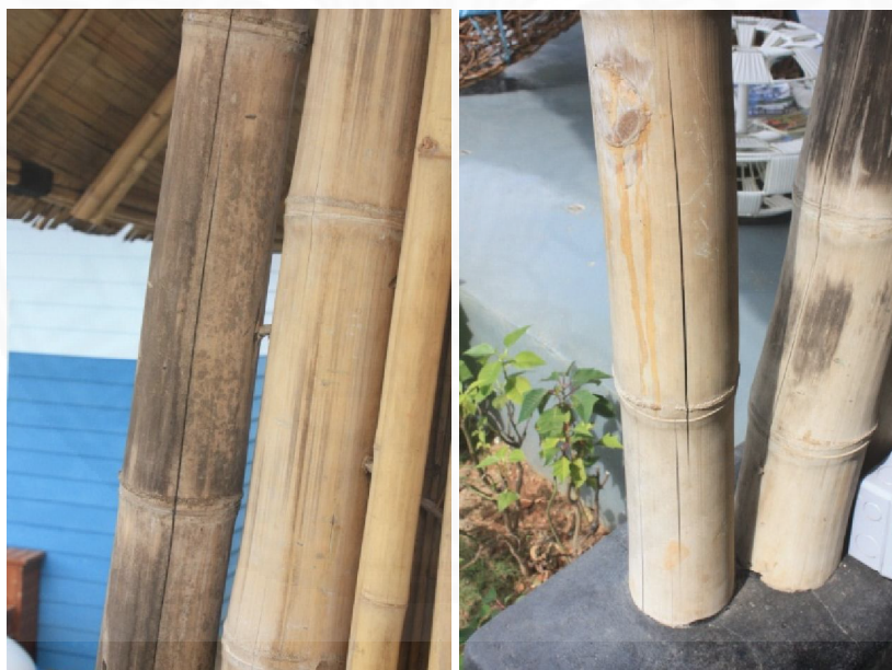
ภาพที่ 4.46 จุดบดพร่องที่เกิดจากความผิดพลาดในการออกแบบ หมายเหตุ. ถ่ายโดยผู้วิจัย, 6 ธันวาคม 2557.
