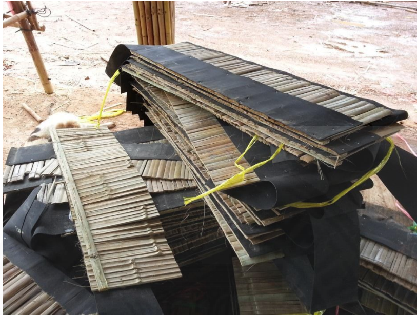
ภาพที่ 4.22 การเตรียมวัสดุบุหลังคา หมายเหตุ. Za-bai Bamboo, 2554.
