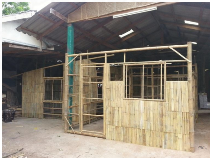
ภาพที่ 1.2 การก่อสร้างบ้านไม้ไผ่ของระบบการก่อสร้างแบบกึ่งสำเร็จรูป (Pre-Fabrication Construction)
