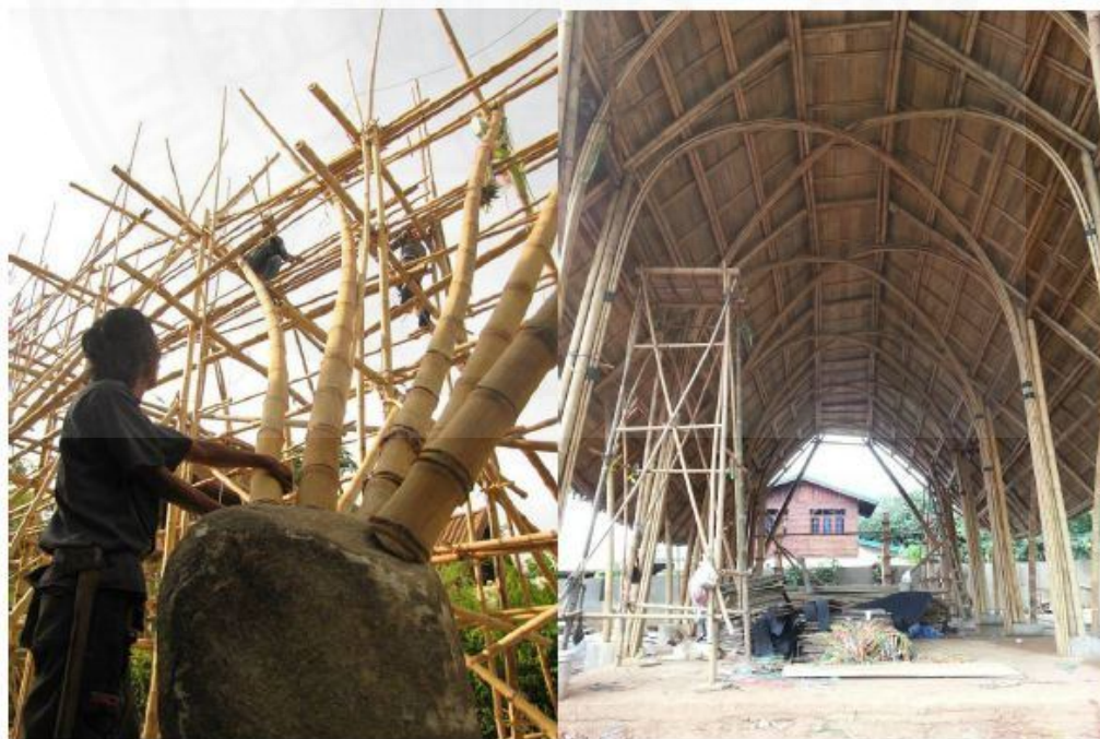
ภาพที่ 4.44 เปรียบเทียบลักษณะโครงสร้างหลักและขนาดไม้ที่ใช้ของอาคารไม้ไผ่โครงสร้างแบบหนาแน่นมากจากระบบการก่อสร้างในที่ (ซ้าย) และจากระบบกิ่งสำเร็จรูป (ขวา)
