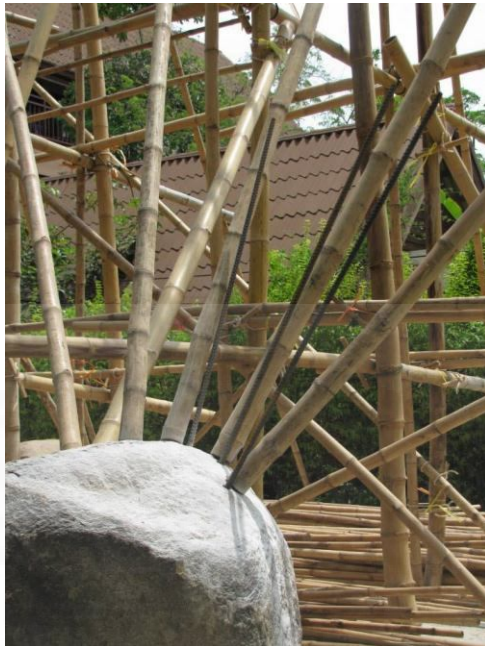
ภาพที่ 4.16 การเจาะฐานเสาเสียบเหล็กเพื่อเตรียมวางเสา หมายเหตุ. สถาบันอาศรมศิลป์, 2556.
