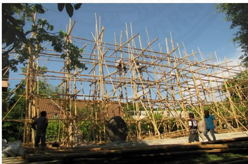
ภาพที่ 4.14 การประกอบโครงไม้ไผ่และตั้งนั่งร้าน (อาคารศาลาไม้ไผ่โครงสร้างแบบซับซ้อน)
