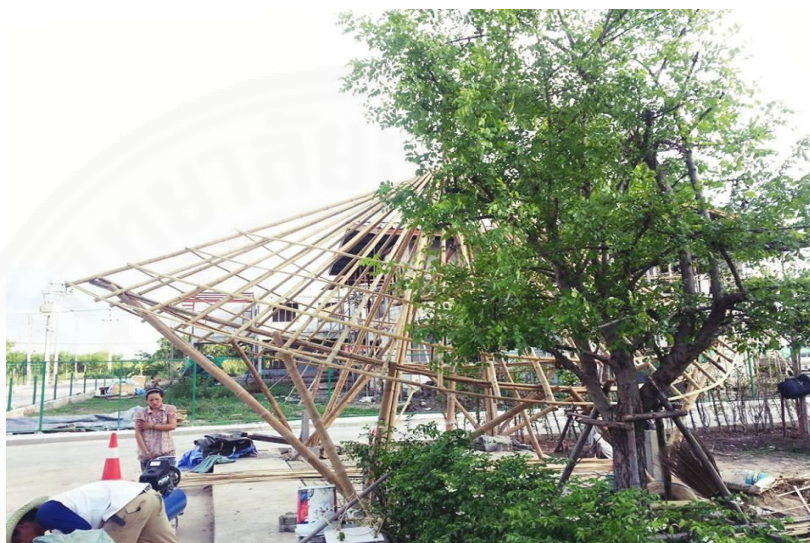
ภาพที่ 4.11 การประกอบโครงสร้างหลังคา
