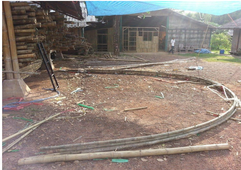
ภาพที่ 4.19 การเตรียมชุดโครงสร้าง หมายเหตุ. ถ่ายโดยผู้วิจัย, 4 สิงหาคม 2556.
