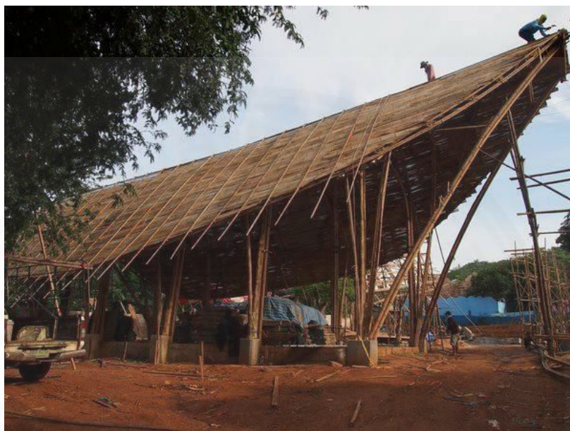
ภาพที่ 4.27 การประกอบโครงสร้างหลังคา หมายเหตุ. ถ่ายโดยผู้วิจัย, 18 กันยายน 2556.
