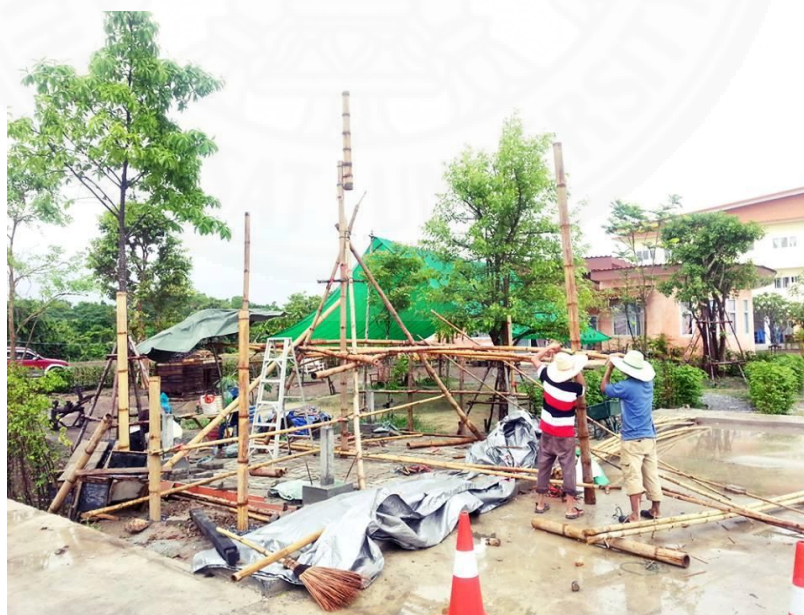
ภาพที่ 4.7 การประกอบโครงไม้ไฟและนั่งร้าน
