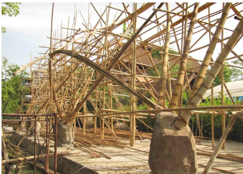
ภาพที่ 4.18 การตั้งเส้นชายคาอาคาร หมายเหตุ. สถาบันอาศรมศิลป์, 2556.
