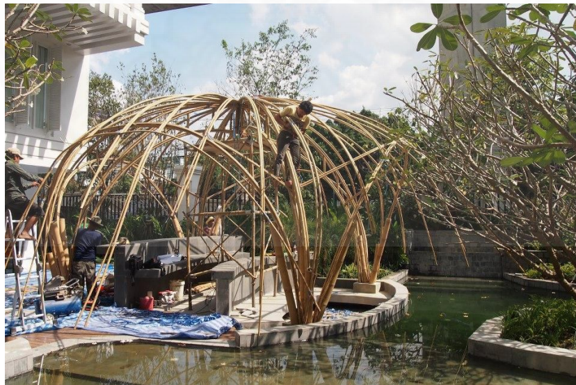
ภาพที่ 4.37 การใช้ไผ่ดัดโค้ง ในโครงสร้างหลักของอาคารไม้ไผ่โครงสร้างแบบหนาแน่นน้อยจากระบบการก่อสร้างกิ่งสำเร็จรูป
