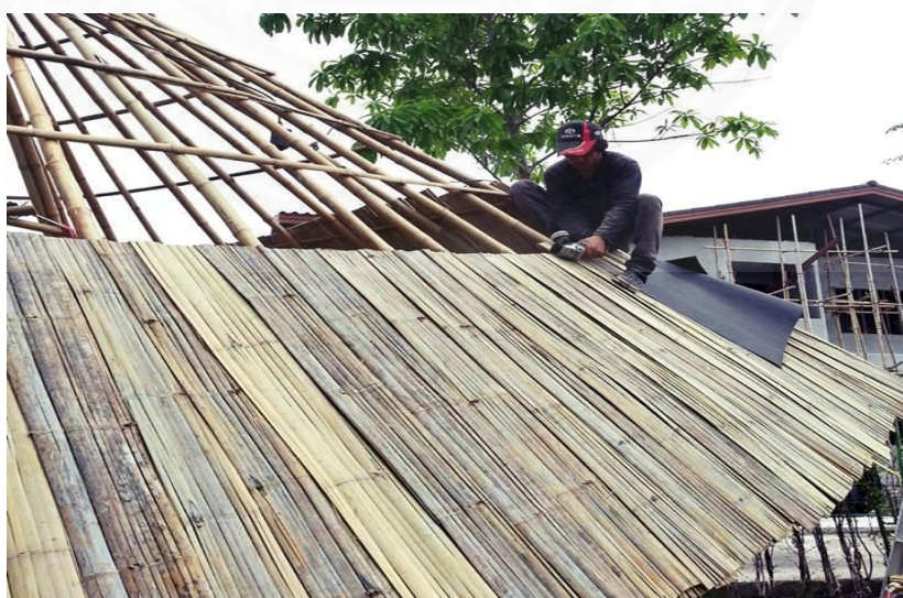
ภาพที่ 4.12 การมุงหลังคาและตัดฝ้าอย่างกันน้ำ
