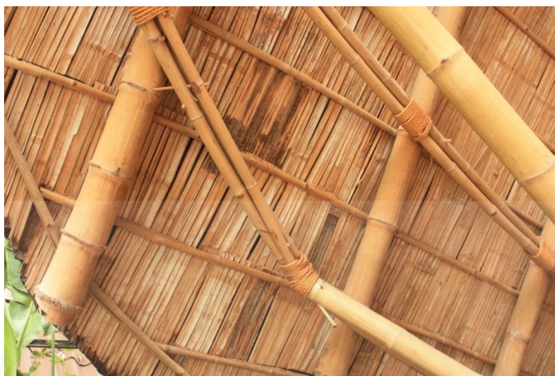
ภาพที่ 4.47 จุดบกพร่องที่เกิดจากความไม่เรียบร้อยในการเก็บงานของช่างและแรงงาน หมายเหตุ. ถ่ายโดยผู้วิจัย, 5 ธันวาคม 2557.
