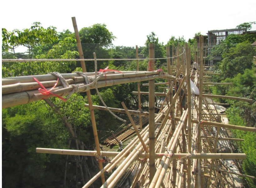
ภาพที่ 4.15 การตั้งอกไก่อาคารไม้ไผ่ หมายเหตุ. สถาบันอาศรมศิลป์, 2556.
