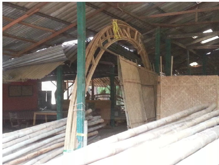
ภาพที่ 2.10 โครงสร้างไม้ไผ่ที่รอการขนส่งไปติดตั้ง หมายเหตุ. ถ่ายโดยผู้วิจัย, 4 สิงหาคม 2556.
