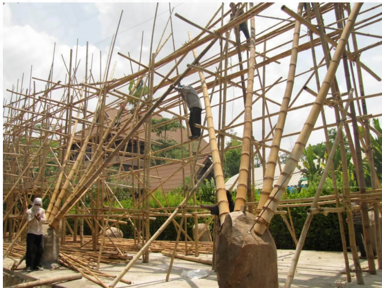
ภาพที่ 4.17 การวางเสาอาคาร หมายเหตุ. สถาบันอาศรมศิลป์, 2556.
