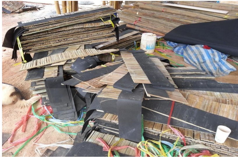
ภาพที่ 4.28 หลังคาไม้ไผ่ทูปที่เตรียมมาจากโรงงาน หมายเหตุ. ถ่ายโดยผู้วิจัย, 18 กันยายน 2556.
