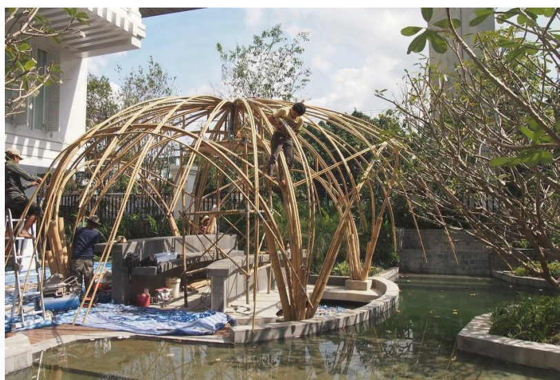
ภาพที่ 4.21 การประกอบโครงสร้างหลังคา
