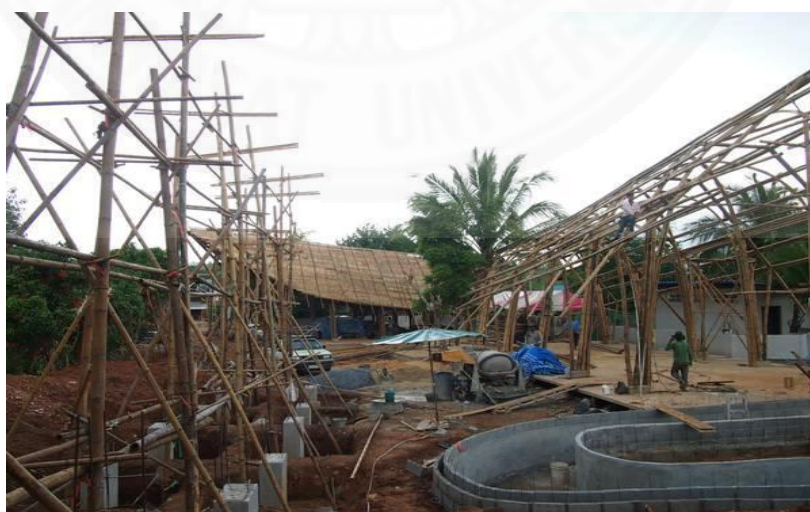
ภาพที่ 4.26 การประกอบชุดโครงสร้าง หมายเหตุ. ถ่ายโดยผู้วิจัย, 14 กันยายน 2556.
