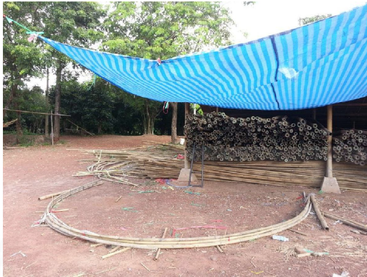
ภาพที่ 2.9 การตัดไม้ไผ่เพื่อเตรียมประกอบเป็นชุดโครงสร้าง หมายเหตุ. ถ่ายโดยผู้วิจัย, 4 สิงหาคม 2556.
