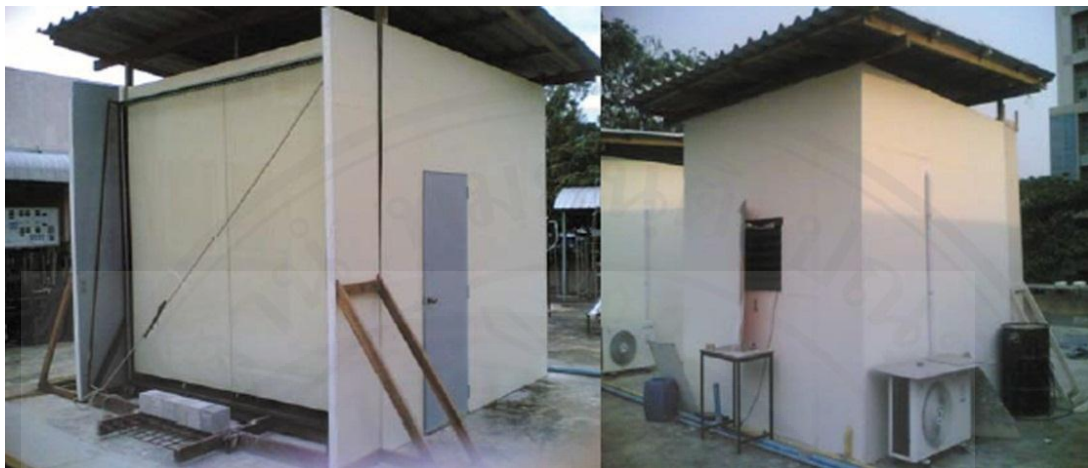
ภาพที่ 2.7 ภาพการทดลองการออกแบบผนังทროมบ์ จาก อัครศิภัสร์ ลีระเศรษฐากร, 2552
