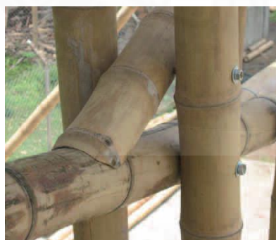
ภาพที่ 2.3 การเชื่อมต่อไม้ไผ่ด้วยวิธีดั้งเดิม. จาก Traditional and Innovative Joints In Bamboo Construction , โดย Andry Widyowijatnoko, 2012, Germany.
