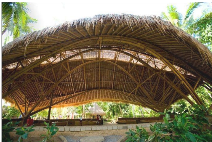
ภาพที่ 2.16 อาคารเรียน Greenest School. จาก www.greenschool.org , 2557.
