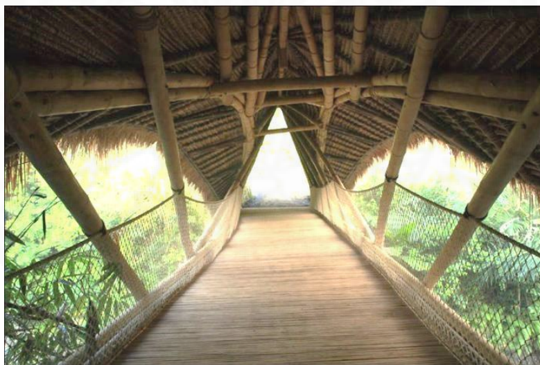
ภาพที่ 2.19 โครงสร้างภายในสะพานไม้ไผ่ภายใน Greenest School. จาก www.greenschool.org , 2557.
