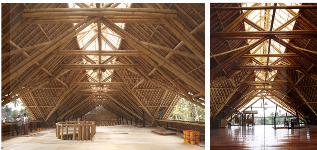
ภาพที่ 2.13 โครงถักรับหลังคาภายในอาคาร Bamboo cathedral. จาก www.bigtreefarms.com , 2557.
