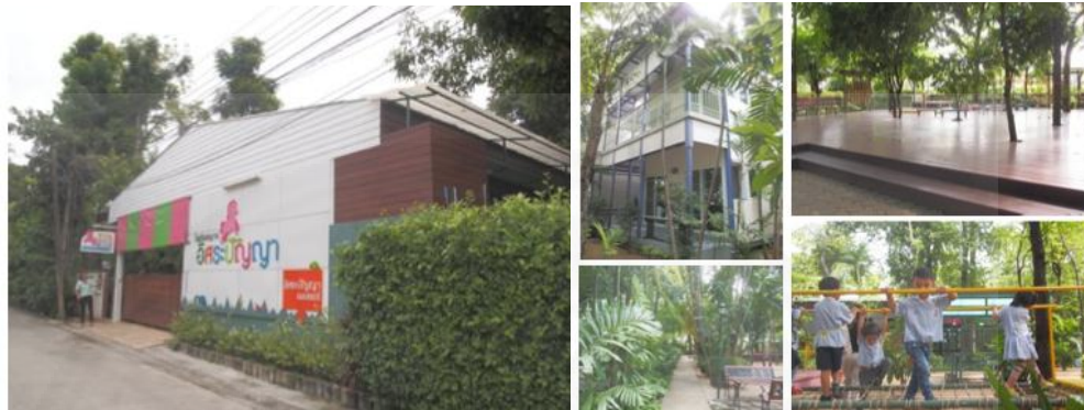
ภาพที่ 2.28 แสดงทัศนียภาพของอาคารเรียนโรงเรียนอิสระปัญญา และพื้นที่สวนโดยรอบ
