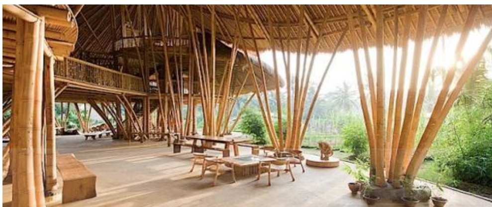
ภาพที่ 2.6 อาคารโครงสร้างไม้ไผ่ที่ใช้แนวคิด Open wall: จาก www.arch2o.com/greenschoolbali , 2014
