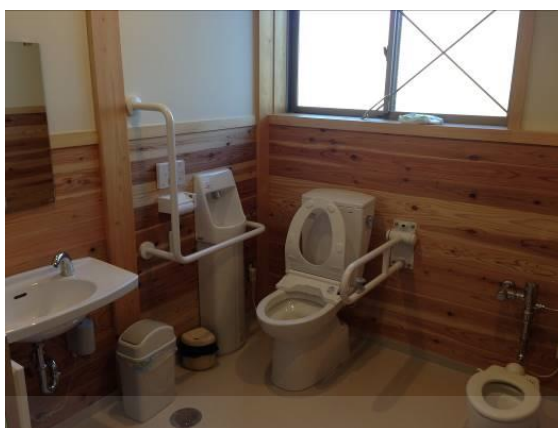
ภาพที่ 2.15 แสดงภาพตำแหน่งการจัดห้องน้ำการติดตั้งอุปกรณ์ราวจับและรูปแบบอ่างล้างมือ ใน Torigoe cafe.
