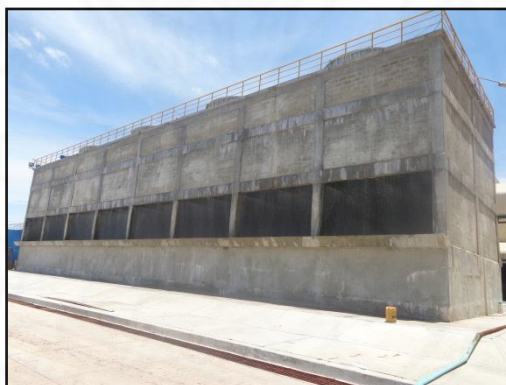
7. หอระบายความร้อนหรือหอทำน้ำเย็น (Cooling tower)
