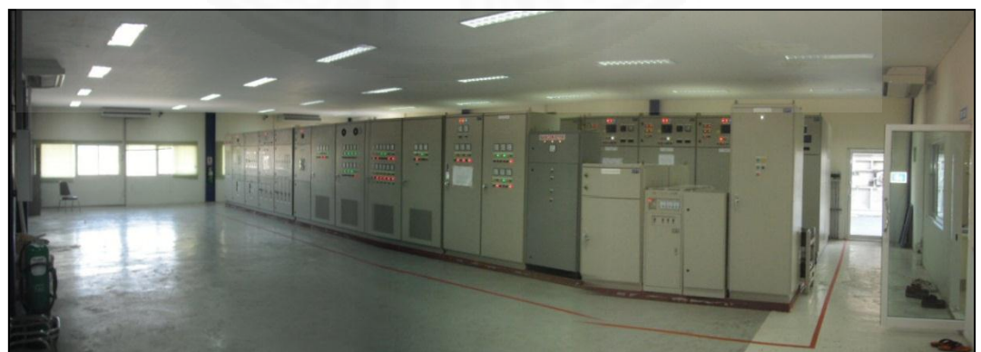
สภาพบริเวณภายในโรงไฟฟ้า 2. อาคาร T.G. & Control Building
