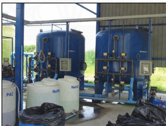
2. ถังกรองทรายหรือถังแอนทราไซท์และถังผลิตน้ำอ่อน (Softener and Sand Filter)
