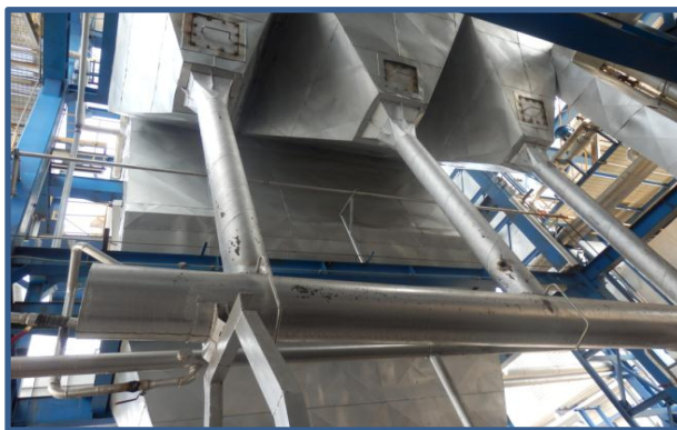
13. ระบบจับฝุ่นโดยใช้ลมหมุนวน (Multi Cyclone)
