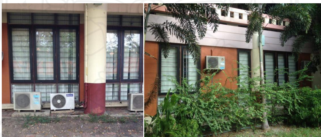
รูปที่ 3.3 สภาพแวดล้อมภายนอกอาคาร
