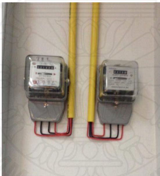
รูปที่ 3.9 มิเตอร์ไฟฟ้า
