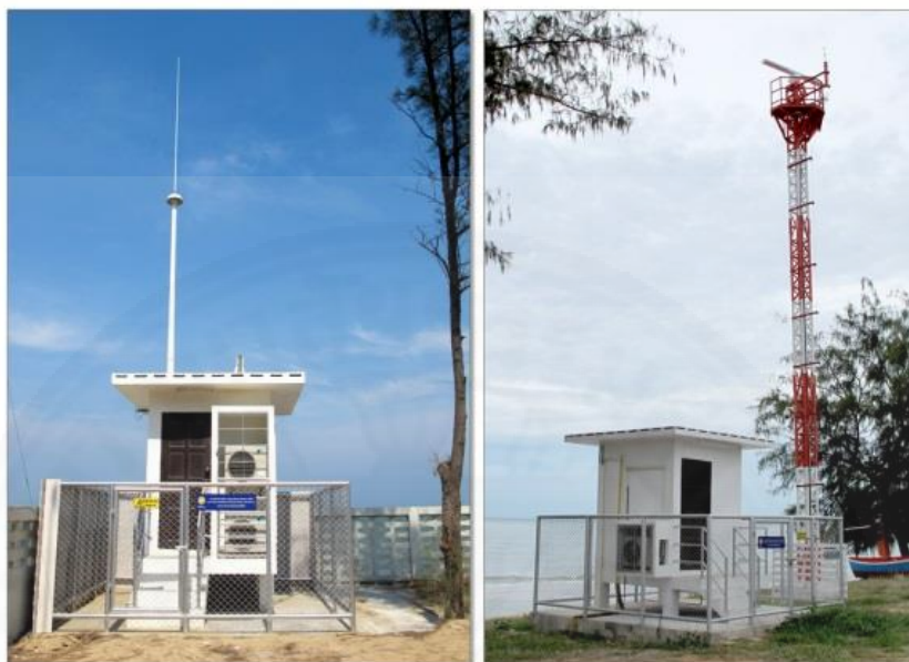
ภาพที่ 2.8 สถานีเรดาร์ชายฝั่งระบบคลื่นวิทยุความถี่สูง (HF Radar) (ภาพซ้าย) และระบบ X-Band (ภาพขวา)
