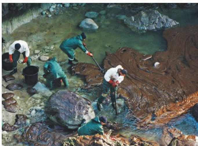
ภาพที่ 2.21 การกำจัดสารกึ่งแข็งจากกระบวนการรวมตัวของน้ำและน้ำมันชนิด Heavy fuel oil ที่มา: The International Tanker Owners Pollution Federation Limited, 2011
