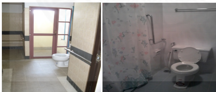
ภาพที่ 5.4 ราวจับในห้องน้ำโครงการบ้านพักบุศยานิเวศน์ และ ราวจับภายในห้องน้ำโครงการสวางคนิเวศ, โดย ผู้วิจัย 2553.
