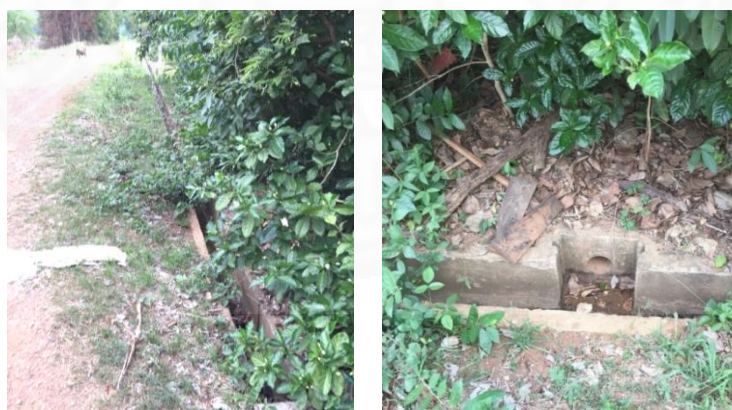
ภาพที่ 4.1 ท่อส่งน้ำจากอ่างเก็บน้ำเขาสามสืบและประตูเปิดน้ำเข้าพื้นที่เกษตร
