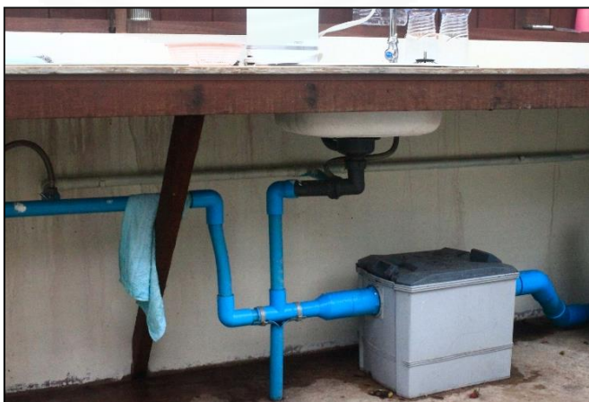
ภาพที่ 4.13 แสดงภาพติดตั้งกล่องดักไขมันที่ท่อระบายน้ำอ่างล้างจาน
