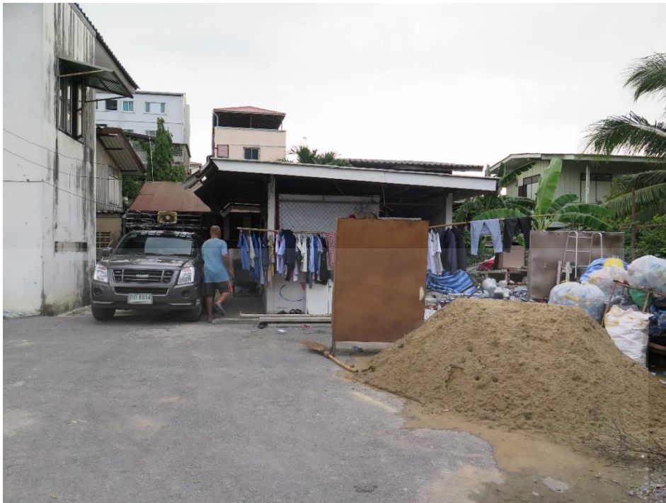
ภาพที่ 5.18 ในช่วงที่ผู้ศึกษาของสนาามศูนย์กำลังดำเนินการสร้างห้องน้ำทางด้านหลังศูนย์เพิ่มเพื่อรองรับคนไร้บ้านในพื้นที่สาธารณะที่จะสามารถมาใช้เพื่ออาบน้ำ-ซักผ้าได้
