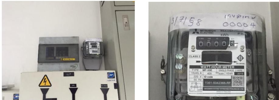
ภาพที่ 3.4 การตรวจวัดพลังงานไฟฟ้าของธนาคารเมื่อทำการแยกวงจรไฟฟ้าแสงสว่างออกจากแผงเมนไฟฟ้าเดิม และทำการติดตั้งมิเตอร์วัดพลังงานไฟฟ้า
