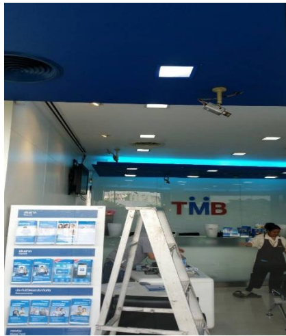
ภาพที่ 4.11 สาขาเดิมในห้างสรรพสินค้า ขณะทำการเปลี่ยนหลอดใหม่เป็นชนิดประสิทธิภาพสูง
