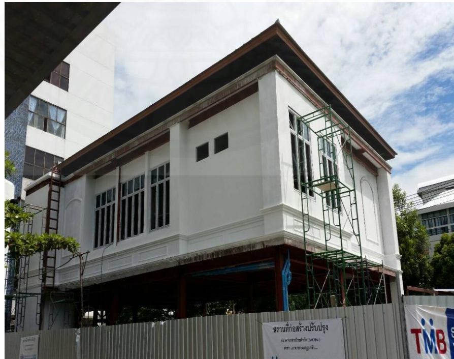
ภาพที่ 3.22 งานก่อสร้างสาขาโรงพยาบาลพระมงกุฎเกล้า
