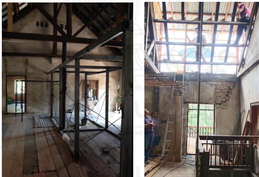
ภาพที่ 3.42 ระหว่างการบูรณะอาคาร
