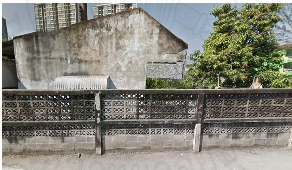
ภาพที่ 2.3 สภาพของที่ดินบริเวณที่เป็นบ้านของเจ้าของเดิม - ด้านที่ติดถนนซอยประชาอุทิศ 9
