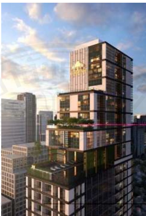
ภาพ 5.13 โครงการ The Loft Asoke
