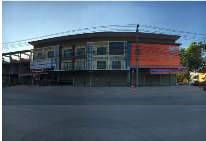
ภาพที่ 5.3 อาคารพาณิชย์ ไม่มีชื่อ 1 (ถนนเลียงเมือง)
