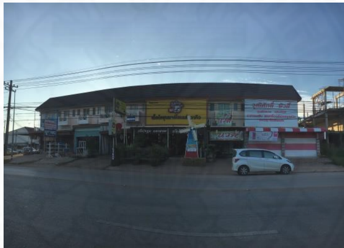
ภาพที่ 5.4 อาคารพาณิชย์ ไม่มีชื่อ 2 (ถนนเลียงเมือง)
