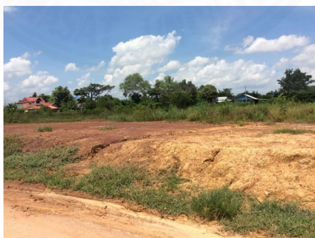
ภาพที่ 3.2 ภาพที่ดินถมแล้วบนที่ตั้งโครงการในปัจจุบัน
