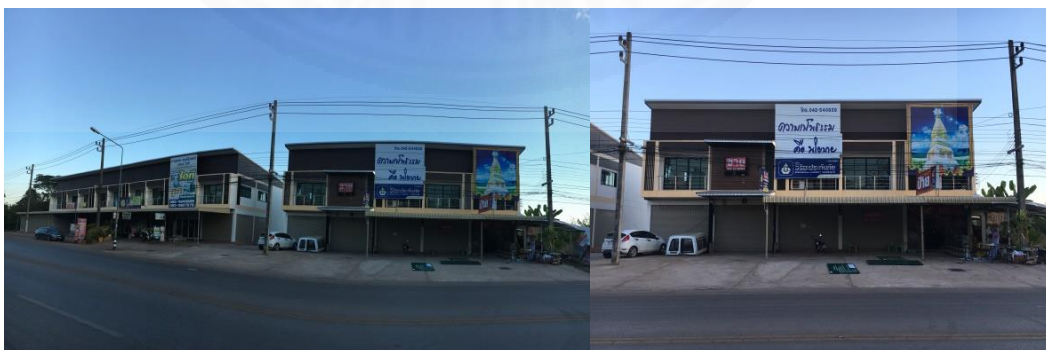
ภาพที่ 5.5 อาคารพาณิชย์ ไม่มีชื่อ 3 (ถนนเลียงเมือง)
