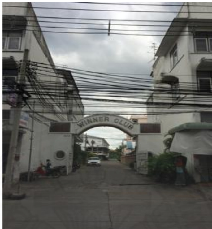
ภาพที่ 3.5 สภาพทางเข้าโครงการฯ
