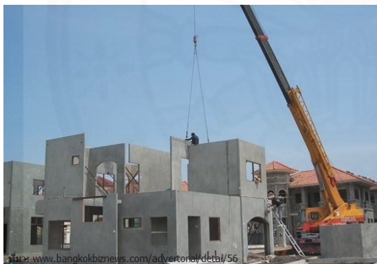
การก่อสร้างด้วยระบบผนังรับน้ำหนัก
