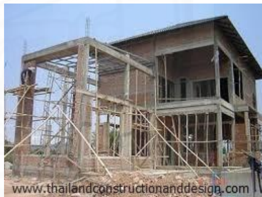
การก่อสร้างด้วยระบบเสา-คาน
