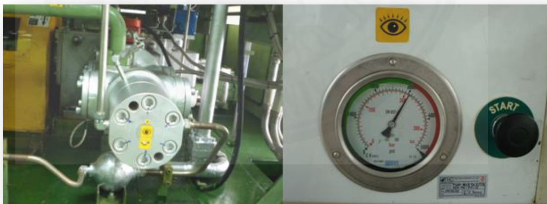
ภาพที่ 4.17 ตัวอย่างการประยุกต์ใช้การควบคุมด้วยการมองเห็น
