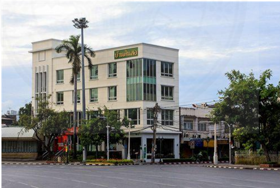
ภาพที่ 2.17 ลักษณะทางกายภาพภายนอกของอาคารเก่าที่ถูกดัดแปลงเป็นโรงแรมขนาดเล็ก.
