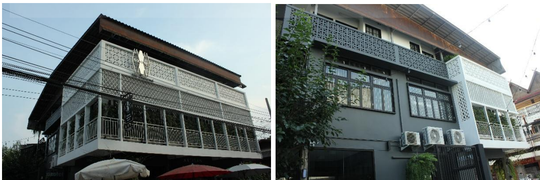
ภาพที่ 4.39 ลักษณะภายนอกอาคารทั้งด้านหน้าและด้านข้างของโรงแรม
