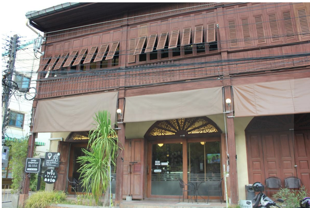
ภาพที่ 4.41 บริเวณทางเข้าหลักของโรงแรมที่ 7
