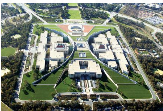
ภาพที่ 2.15 แสดงหลังคาอาคารรัฐสภาประเทศ ออสเตรเลีย ที่มีลักษณะเป็นผืนหญ้าโค้งให้ประชาชนสามารถเดินขึ้นไปยังหลังคาได้, เว็บไซต์ : http://www.greenmaster.it/ , สืบค้น วันที่ 10 ธันวาคม 2558.
