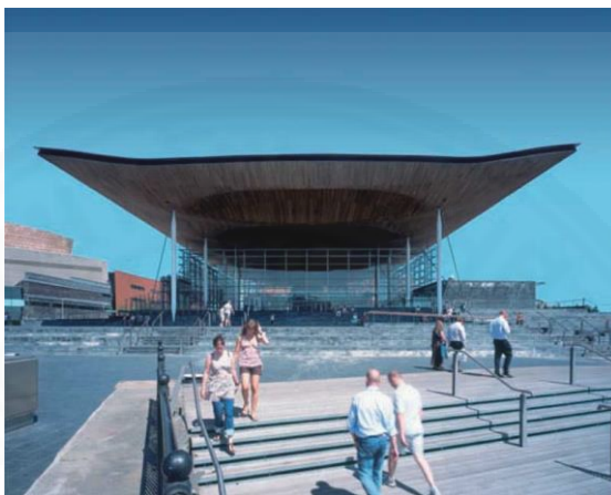
ภาพที่ 2.11 แสดงอาคารรัฐสภา เวลส์, เว็บไซต์ http://www.e-architect.co.uk/ , สืบค้น วันที่ 10 ธันวาคม 2558.
