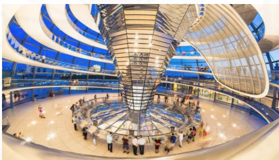
ภาพที่ 2.17 แสดงหลังคาโดมอาคารรัฐสภาประเทศ เยอรมัน ที่มีพื้นที่ทางเดินสำหรับประชาชนเป็นเกลียว และสามารถมองเห็นห้องประชุมรัฐสภา, เว็บไซต์ ที่มา : http://www.shutterstock.com/ , สืบค้น วันที่ 12 ธันวาคม 2558.
