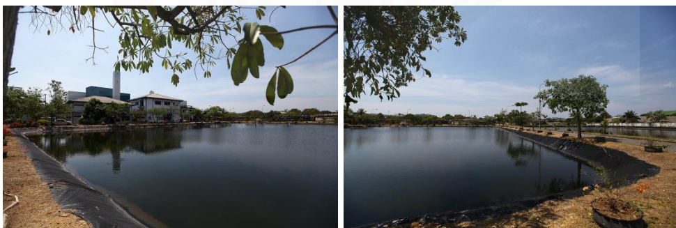
ภาพที่ ก.6 โรงงานปรับปรุงคุณภาพน้ำ
