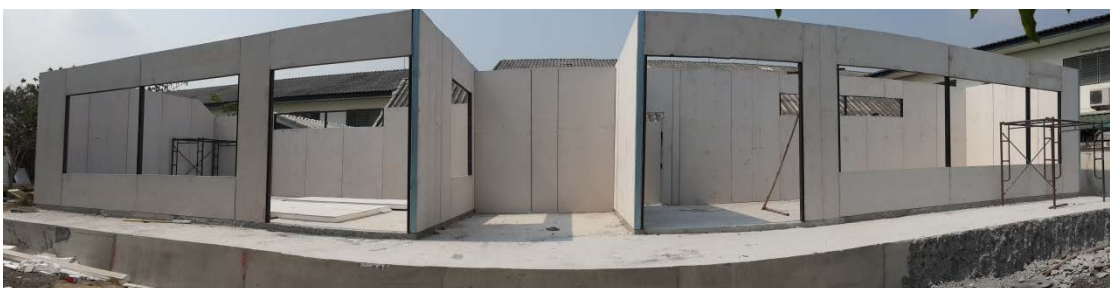
ภาพที่ 4.45 การติดตั้งแผ่นผนังโดยเริ่มจากการติดตั้งที่มุมอาคาร และทำการค้ำยัน
