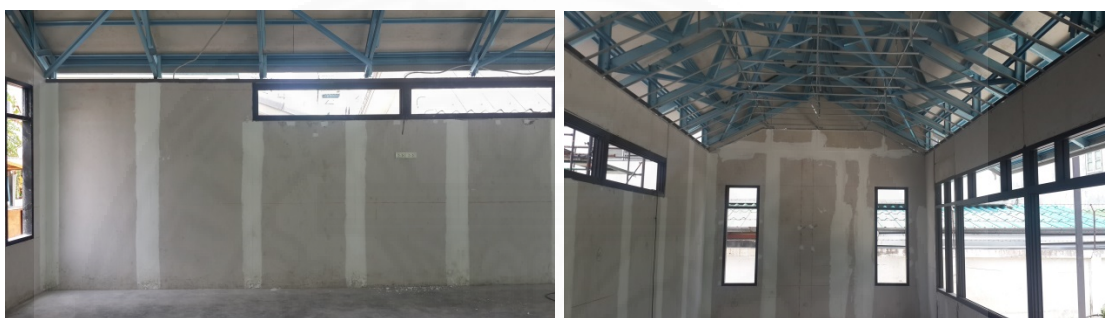
ภาพที่ 4.50 การเก็บงานรอยต่อด้วยปูนฉาบผิวบาง
