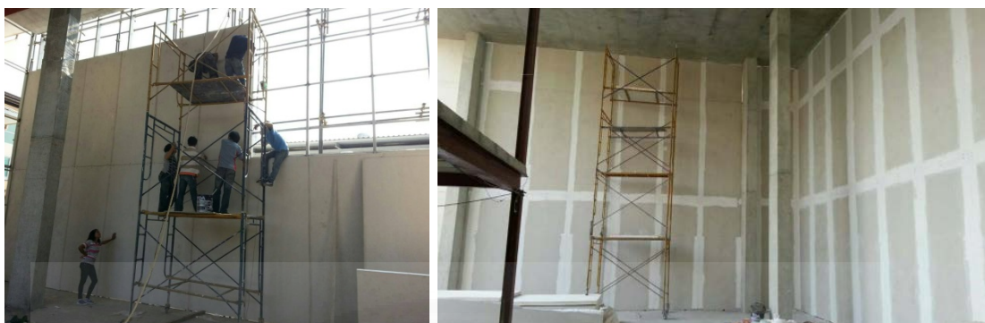
ภาพที่ 4.64 ความสูงของผนังอาคาร ส่งผลต่อระยะเวลาในการติดตั้งและการเก็บรอยต่อ, จาก บริษัท A, 2558
