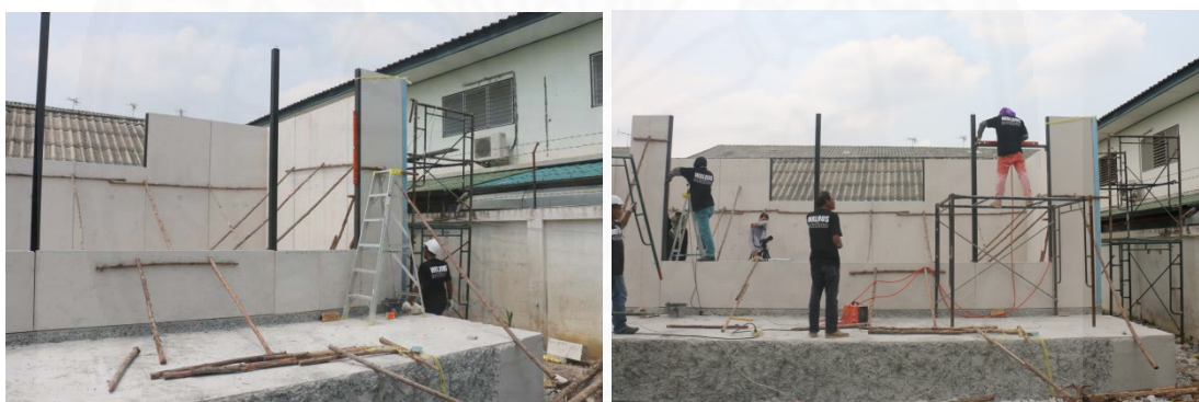
ภาพที่ 4.47 การเสริมเหล็กรูปพรรณ บริเวณช่องเปิดขนาดใหญ่
