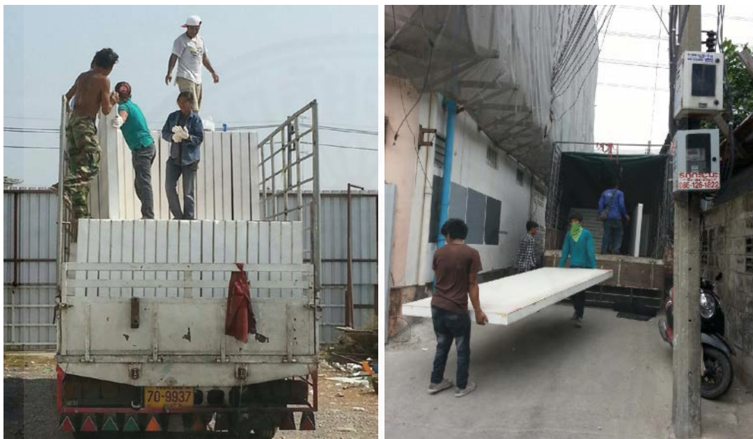
ภาพที่ 4.21 การขนส่งแผ่นฉนวนโครงสร้างโดยรถบรรทุก 6 ล้อ ของอาคารกรณีศึกษาที่ 2, จากบริษัท A, 2558
