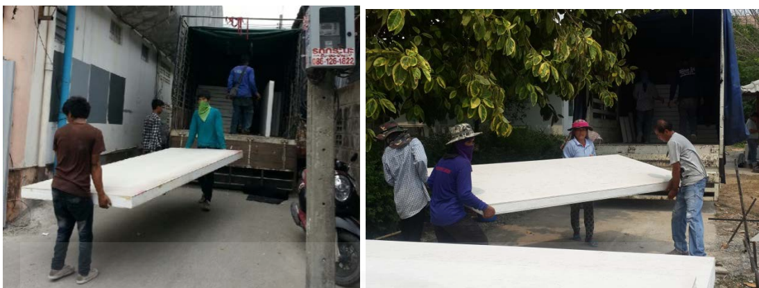
ภาพที่ 4.4 การยกแผ่นฉนวนโครงสร้างของบริษัท A, จาก บริษัท A, 2558
