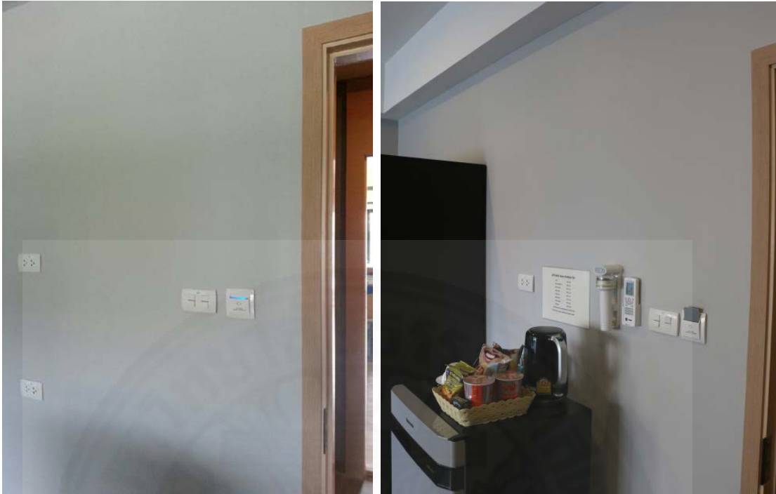
ภาพที่ 4.26 ผนังบริเวณที่ติดตั้งงานระบบต่างๆ หลังจากเก็บงานเรียบร้อยแล้ว
