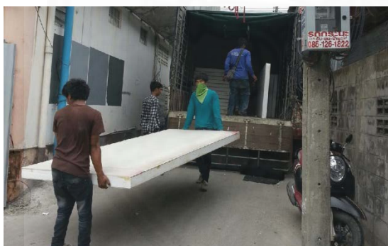
ภาพที่ 4.62 ชิ้นส่วนมาตรฐานที่ถูกขนส่งมายังสถานที่ก่อสร้าง ของอาคารกรณีศึกษาที่ 2, จาก บริษัท A, 2558
