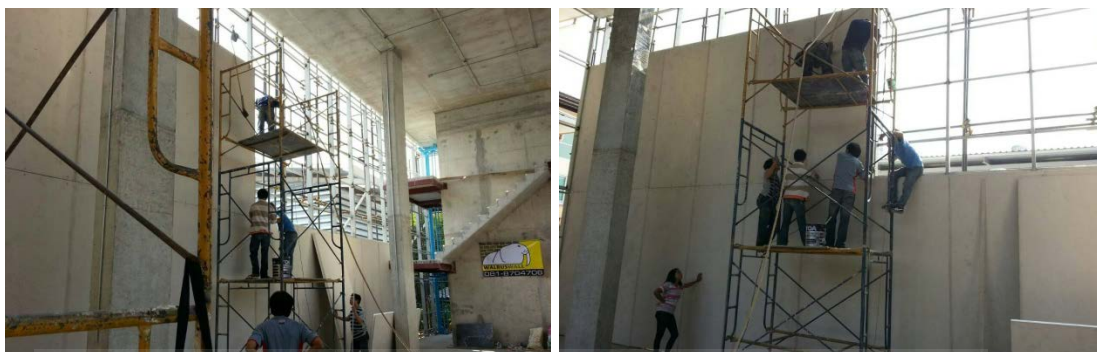
ภาพที่ 4.67 การติดตั้งผนังของอาคารกรณีศึกษาที่ 1
