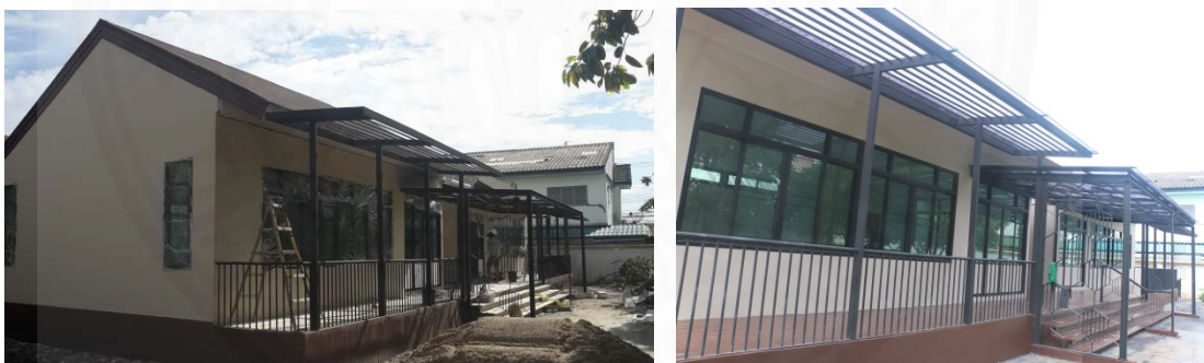
ภาพที่ 4.54 พื้นที่ภายนอกอาคารหลังจากเก็บงานและทาสี
