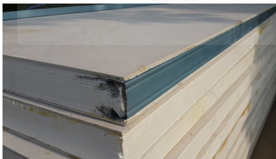
ภาพที่ 4.63 การติดตั้งเหล็กกรีดเย้นที่ด้านข้างของชิ้นส่วน ของอาคารกรณีศึกษาที่ 5
