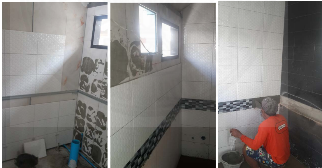
ภาพที่ 4.51 การปูกระเบื้องบนแผ่นผนังฉนวนโครงสร้าง
