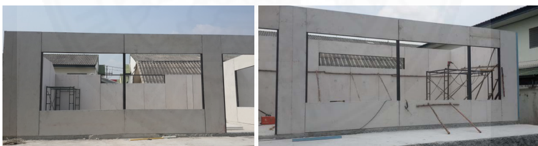
ภาพที่ 4.70 การติดตั้งผนังที่มีช่องเปิดขนาดใหญ่ของอาคารกรณีศึกษาที่ 5
