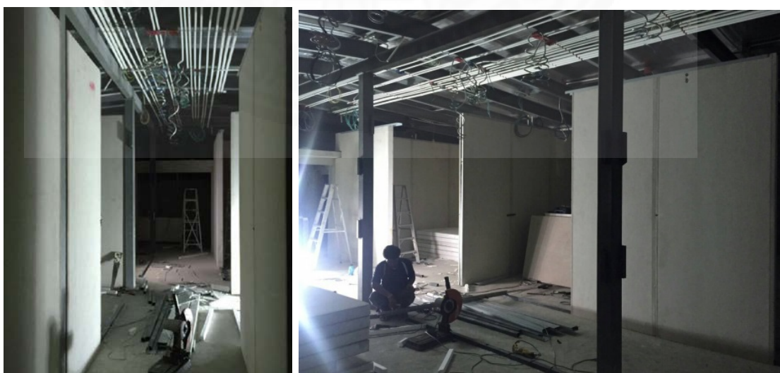
ภาพที่ 4.22 การติดตั้งส่วนและอุปกรณ์ในการติดตั้งที่หน้างานก่อสร้าง, จาก บริษัท A, 2558
