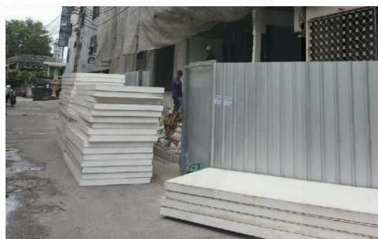
ภาพที่ 4.62 ชิ้นส่วนมาตรฐานที่ถูกขนส่งมายังสถานที่ก่อสร้าง ของอาคารกรณีศึกษาที่ 2, จาก บริษัท A, 2558
