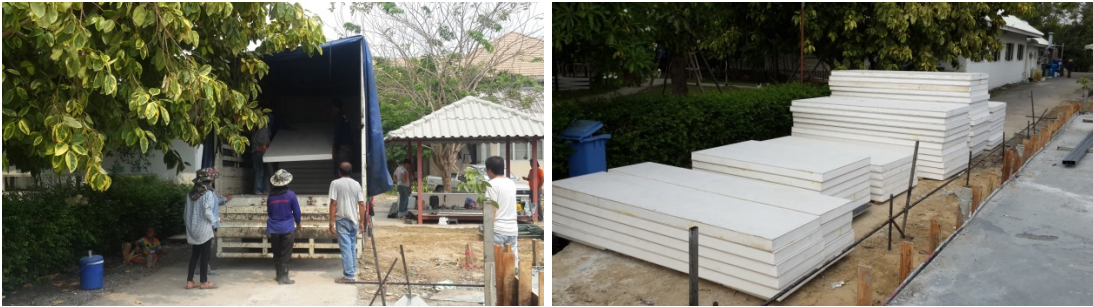
ภาพที่ 4.40 แผ่นฉนวนโครงสร้างที่ถูกส่งมายังสถานที่ก่อสร้าง
