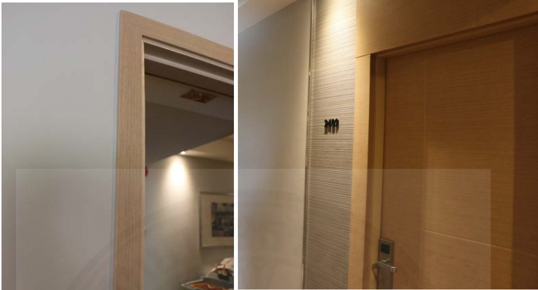
ภาพที่ 4.28 การเก็บรอยต่อระหว่างผนังกับวงกบประตู
