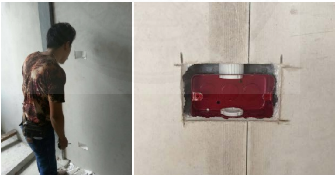
ภาพที่ 4.25 การเจาะช่องเพื่อใส่กล่องไฟฟ้า, จาก บริษัท A, 2558
