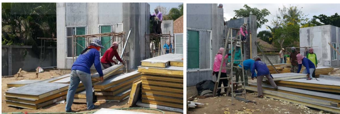
ภาพที่ 4.3 การยกแผ่นฉนวนโครงสร้างของบริษัท B, จาก บริษัท B, 2558
