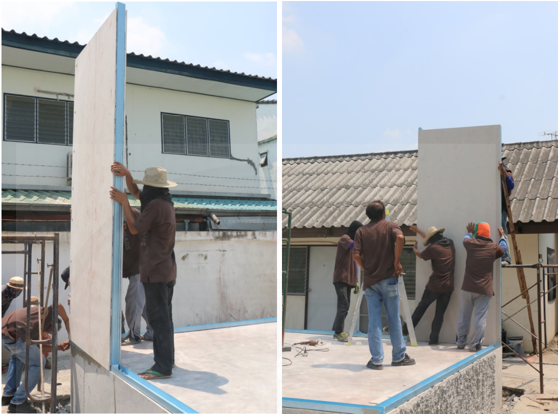
ภาพที่ 4.44 การติดตั้งแผ่นผนังฉนวนโครงสร้างแผ่นแรก และทำการค้ำยัน
