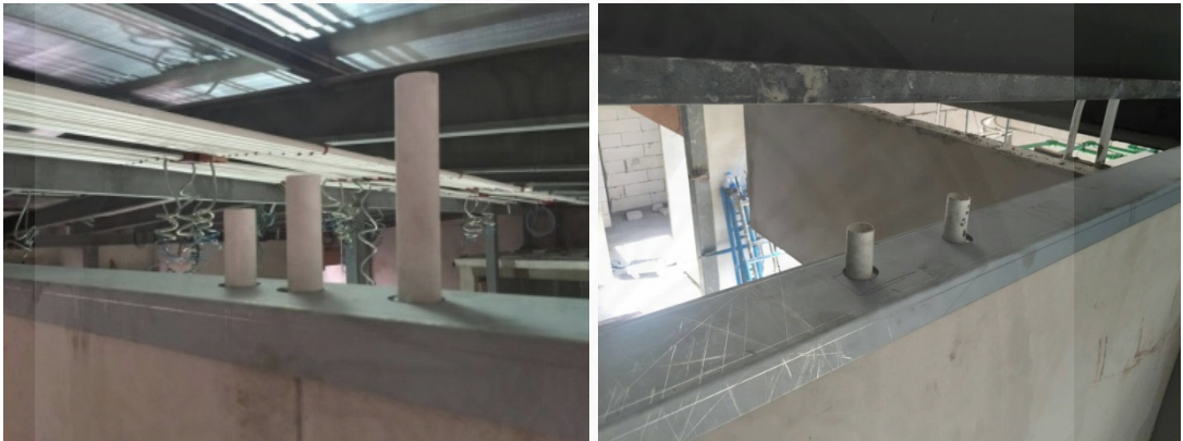
ภาพที่ 4.24 การร้อยท่อไฟฟ้า โดยไม่ต้องกรีดผนัง, จาก บริษัท A, 2558
