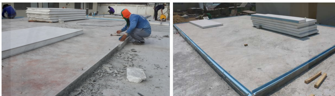
ภาพที่ 4.8 แนวผนังของกรอบอาคาร และการฝังฟูกเหล็กที่พื้นคอนกรีต
