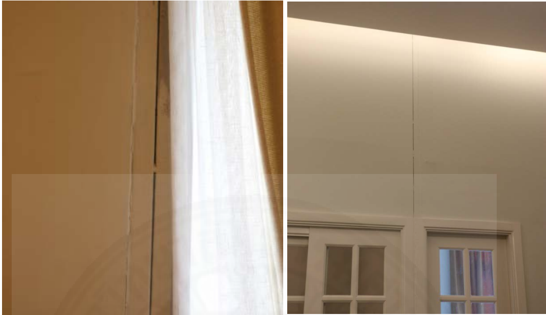
ภาพที่ 4.19 รอยร้าวระหว่างรอยของผนังกับวงกบ และของแผ่นที่มีช่องเปิด
