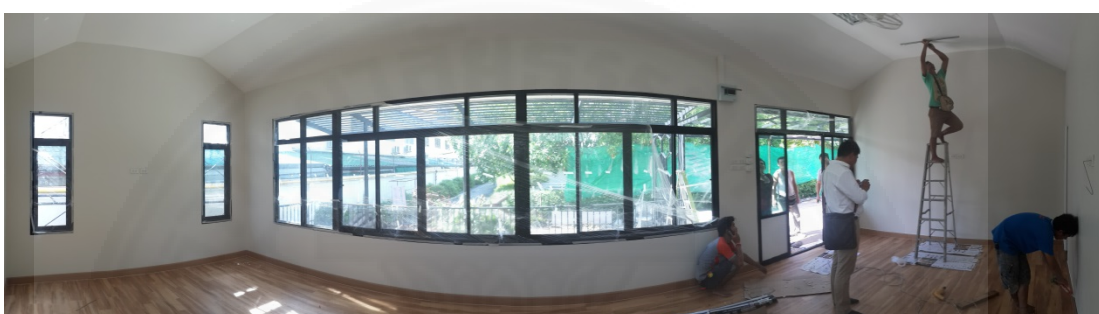
ภาพที่ 4.53 พื้นที่ภายในห้องประชุมหลังจากเก็บงานและทาสี
