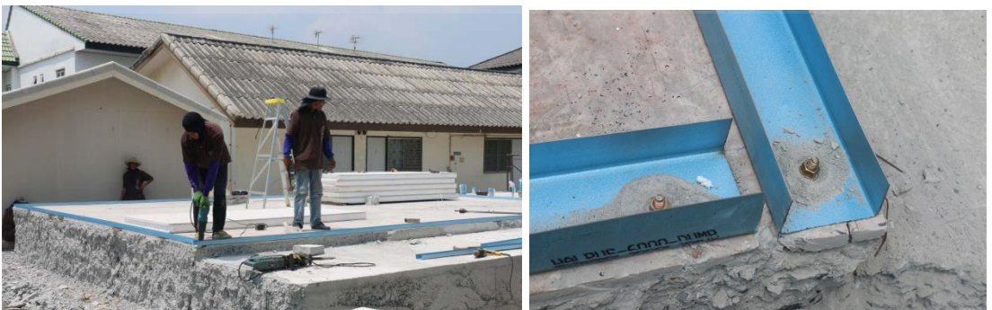
ภาพที่ 4.43 การติดตั้งรางตัวยูที่พื้น เพื่อใช้ในการติดตั้งแผ่นผนัง
