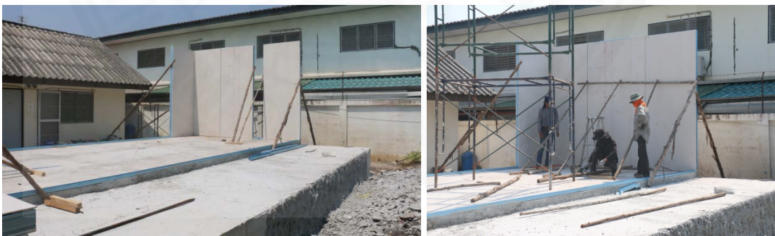
ภาพที่ 4.45 การติดตั้งแผ่นผนังโดยเริ่มจากการติดตั้งที่มุมอาคาร และทำการค้ำยัน
