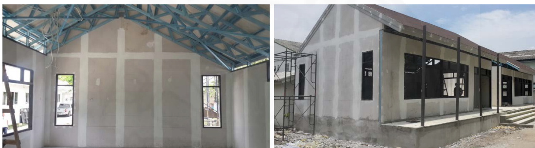
ภาพที่ 4.69 การติดตั้งผนังของอาคารกรณีศึกษาที่ 5
