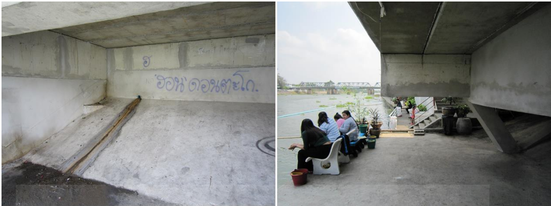
ภาพที่ 4.46 แสดงทำน้ำด้านล่างที่เป็นมูมอับ (ซ้าย) และคานรับพื้นด้านบนที่มีระดับต่ำทำให้ไม่สามารถเดินได้อย่างสะดวก (ต่อ), โดย ผู้วิจัย
