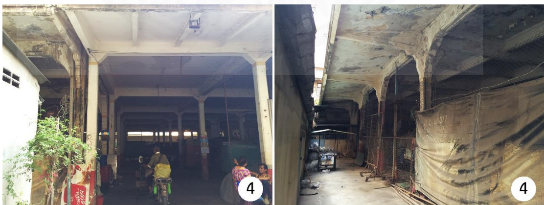
ภาพที่ 5.24 อาคารและพื้นที่ว่างที่เหมาะสมในการพัฒนาเป็นพื้นที่สาธารณะ (ต่อ), โดย ผู้วิจัย
