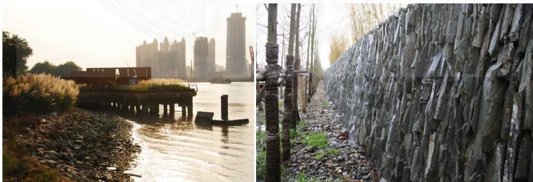
ภาพที่ 4.70 การใช้แนวกองหินเพื่อให้พืชพรรณต่างๆ สามารถเจริญเติบโตและป้องกันการกัดเซาะ. จาก archdaily เรียกใช้เมื่อ 30 มีนาคม 2559, http://www.archdaily.com/131747/shanghai-houtan-park-turenscape
