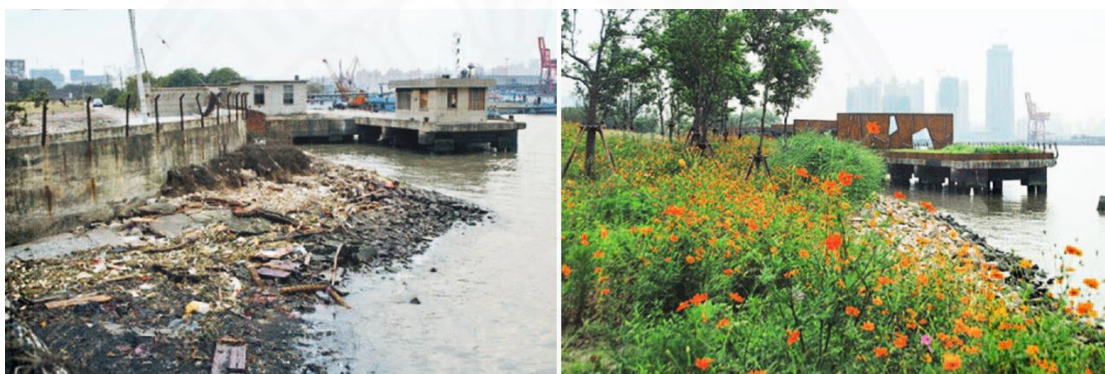
ภาพที่ 4.71 การใช้พืชพรรณเพื่อป้องกันการกัดเซาะและบำบัดน้ำเสีย Shanghai Houtan Park. จาก archdaily เรียกใช้เมื่อ 30 มีนาคม 2559, http://www.turenscape.com/english/news/view.php?id=213
