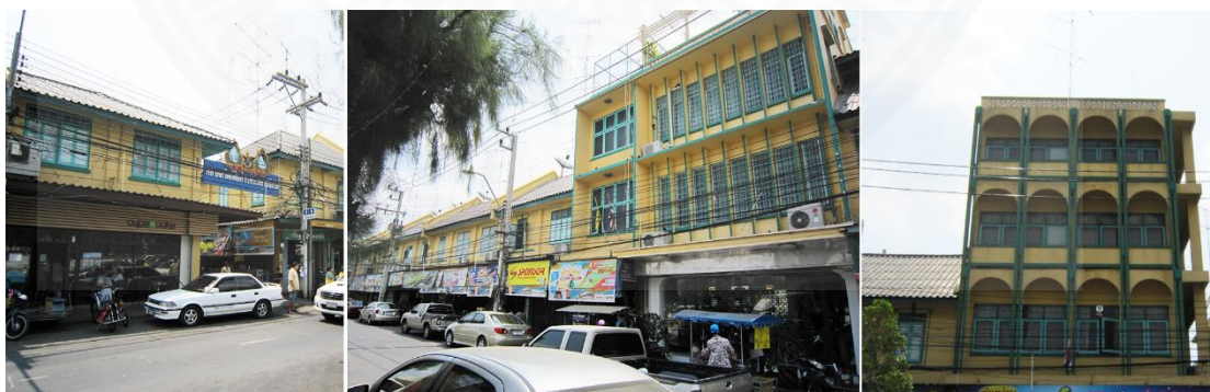
ภาพที่ 4.63 การอนุรักษ์อาคารเก่าโดยการใช้โทนสีที่คล้ายคลึงกันของจังหวัดราชบุรี, โดย ผู้วิจัย
