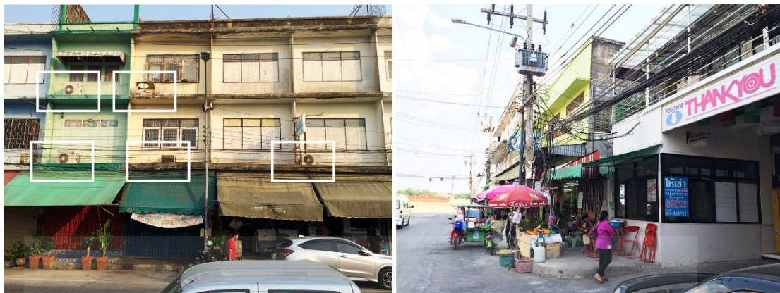
ภาพที่ 6.11 การติดตั้งคอลย์ร้อนเครื่องปรับอากาศที่ไม่เป็นระเบียบ (ซ้าย) และเสาไฟฟ้ากีดขวางทางเดิน (ขวา), โดย ผู้วิจัย
