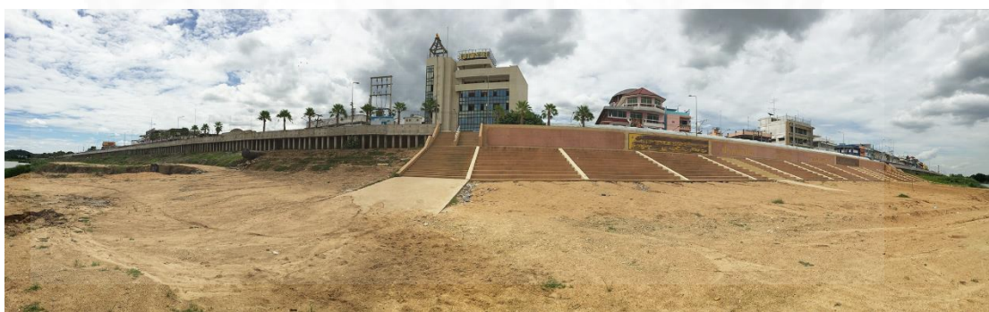
ภาพที่ 4.54 ลักษณะพนักันน้ำคอนกรีตจังหวัดนครสวรรค์, โดย ผู้วิจัย
