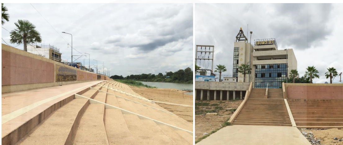
ภาพที่ 4.49 พนังป้องกันน้ำคอนกรีตแบบขั้นบันไดจังหวัดนครสวรรค์, โดย ผู้วิจัย
