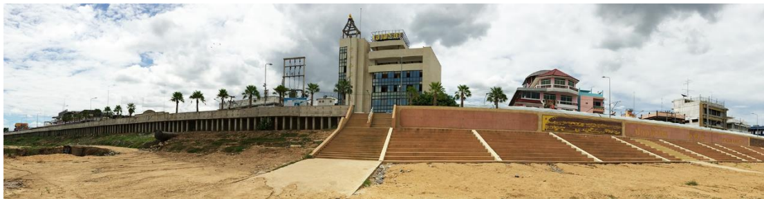
ภาพที่ 5.39 พนังป้องกันน้ำท่วมที่ก่อสร้างขึ้น, โดย ผู้วิจัย
