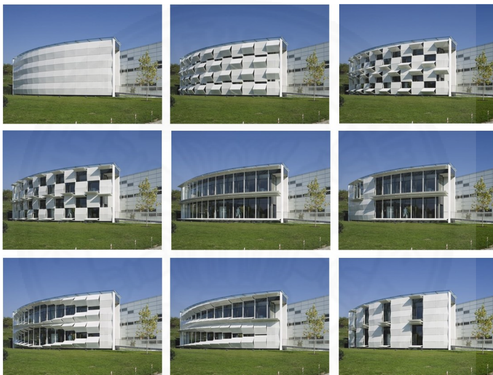
ภาพที่ 2.9 ตัวอย่างรูปแบบการสร้างช่องเปิดของ Kiefer Technic Showroom. จาก http://mod.crida.net/thesis/S1-2013/category/uncategorized/page/2/ , โดย Abbie, 2013
