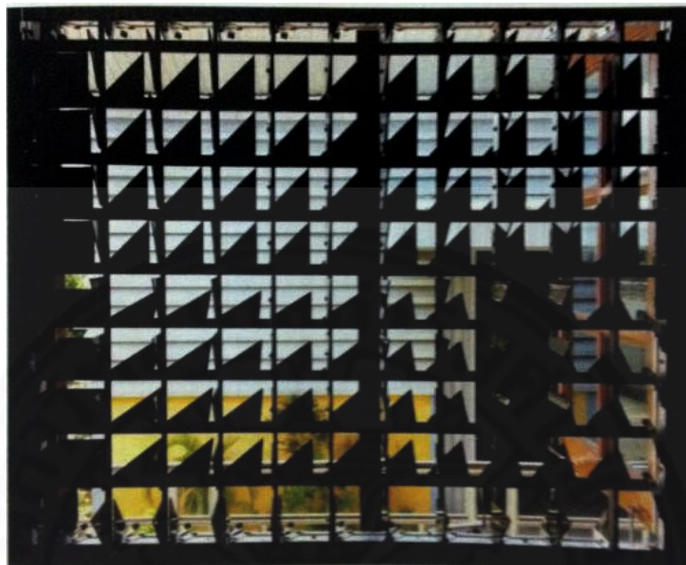
ภาพที่ 2.13 ต้นแบบระบบควบคุมแสงธรรมชาติอัตโนมัติ, จาก ระบบควบคุมแสงธรรมชาติอัตโนมัติภายในสถาปัตยกรรมผ่านการตอบสนองต่อพฤติกรรมการใช้พื้นที่, โดยพิสัย สืบบำรุงสาสน์, 2557
