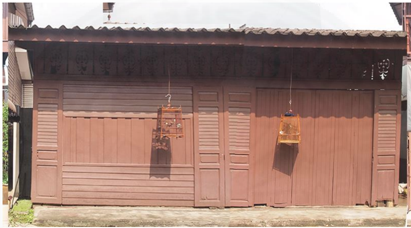
ภาพที่ 4.9 อาคารหมายเลข 1 รูปแบบ ก. จาก ผู้วิจัย, 20 ธันวาคม 2558
