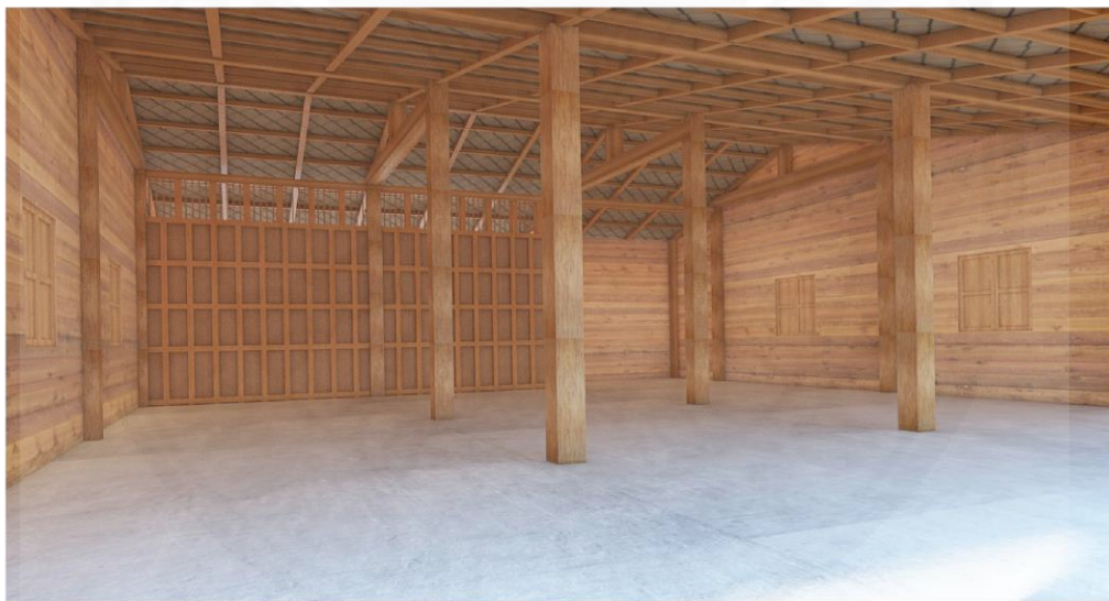
ภาพจำลองแสดงเสาคอนกรีตและกำแพงอิฐบล็อกที่ถูกปิดทับด้วยไม้เนื้อแข็งหลังการบูรณะ ภาพที่ 5.27 ภาพจำลองกำแพงและเสาก่อนและหลังการปรับเปลี่ยนวัสดุ. จาก ผู้วิจัย, 2559
