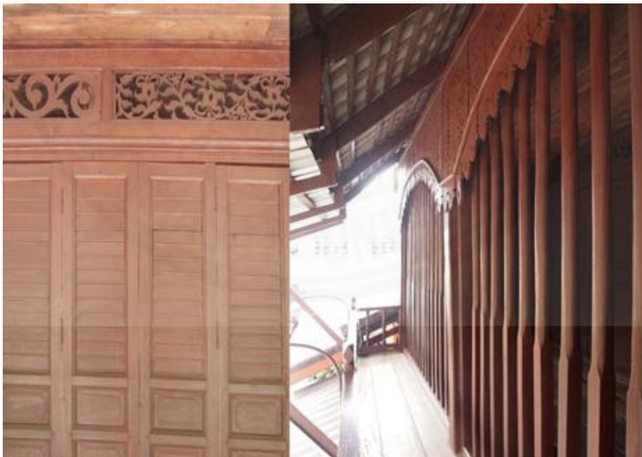
ภาพที่ 4.30 แสดงรายละเอียดการฉลุช่องระบายลม และระเบียงชั้นนอก. จาก ผู้วิจัย, 20 ธันวาคม 2558
