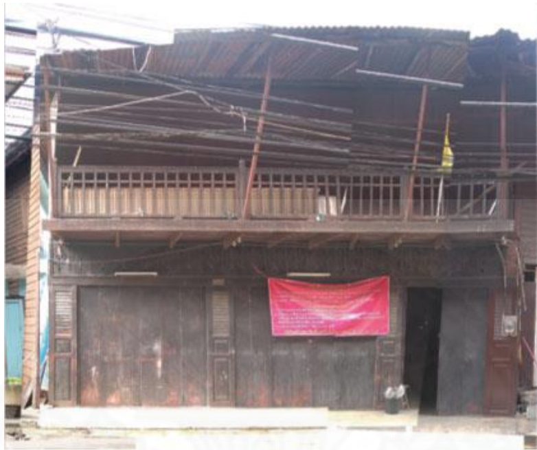
ภาพที่ 4.15 อาคารหมายเลข 6 รูปแบบ ง. จาก ผู้วิจัย, 20 ธันวาคม 2558
