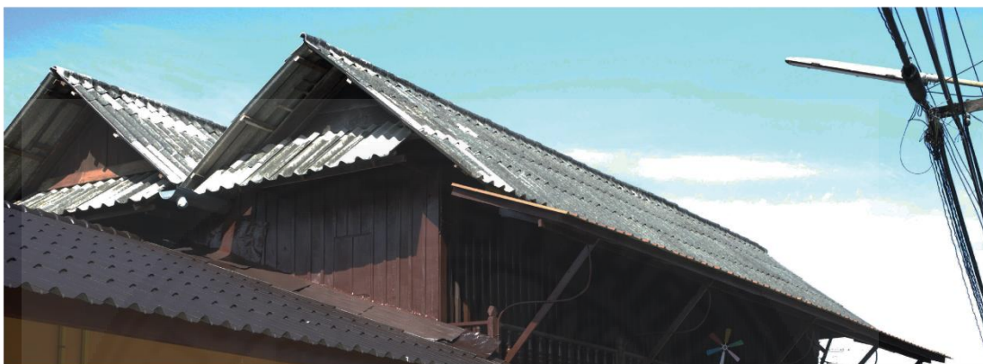
วัสดุบุหลังคาปัจจุบัน
