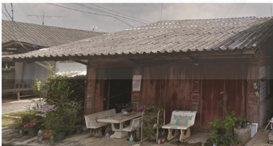
ภาพที่ 4.11 อาคารหมายเลข 7 รูปแบบ ข. จาก ผู้วิจัย, 20 ธันวาคม 2558
