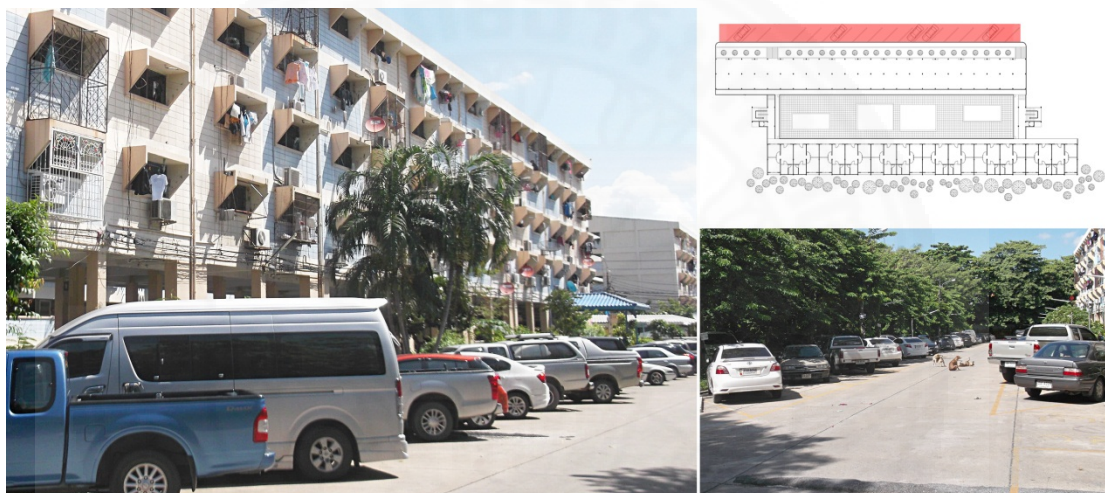
ภาพที่ 4.43 ที่จอดรถข้างอาคารแฟลต. ภาพถ่ายโดย ผู้วิจัย วันที่ 27 กันยายน 2558.
