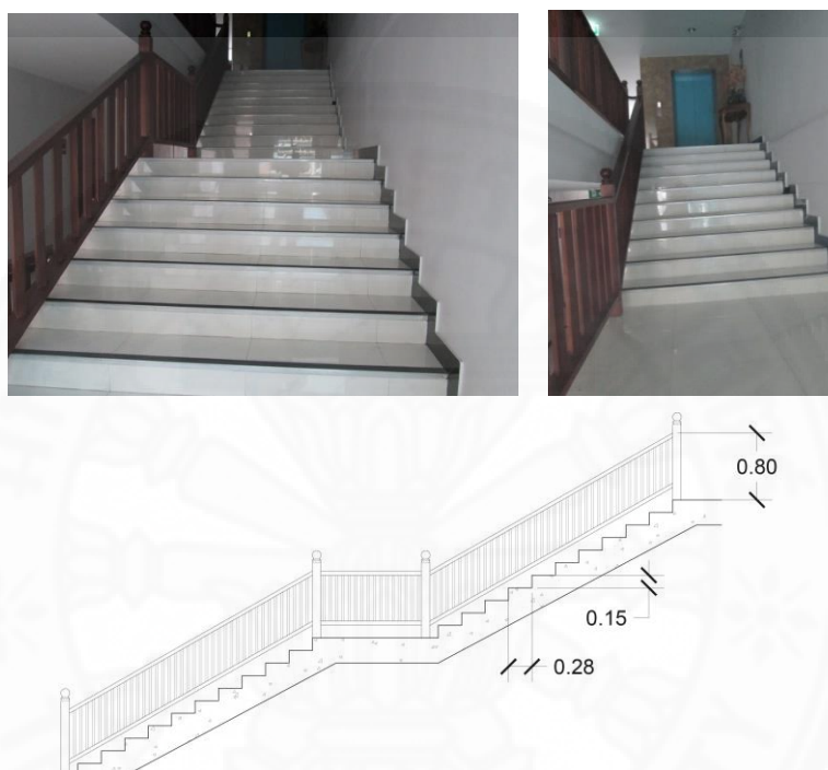
ภาพที่ 4.41 แสดงบันไดหลัก โครงการ Q
