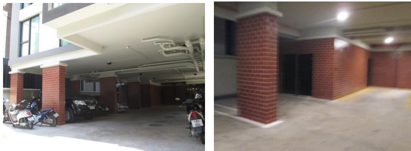
ภาพที่ 4.50 ที่จอดรถ โครงการ U
