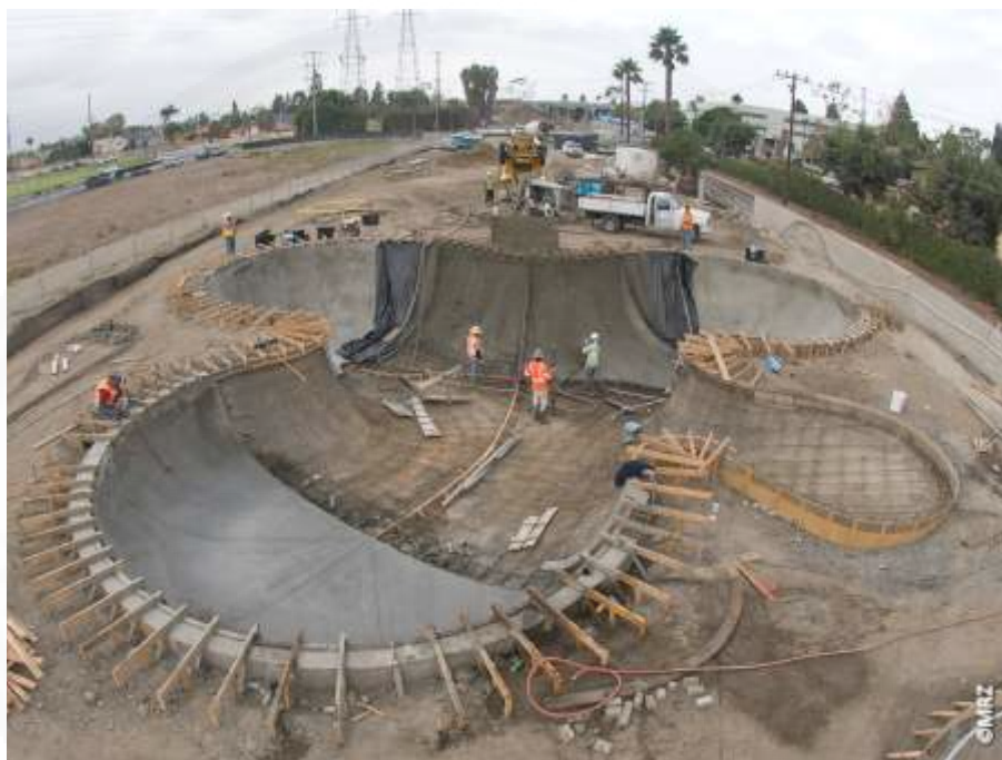
ภาพที่ 2.4 การหล่อในที่เพื่อสร้างลานสเก็ตบอร์ดในรัฐแคลิฟอร์เนีย. จาก
