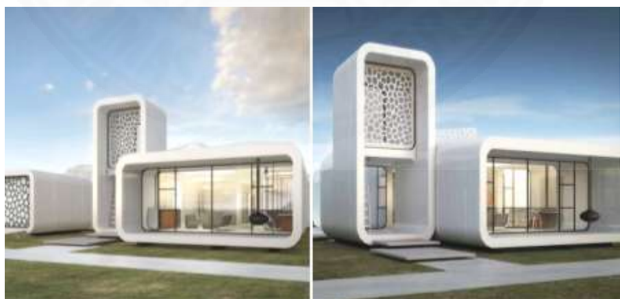
ภาพที่ ผ.22 งานออกแบบอาคารสำนักงานที่สร้างด้วยเทคโนโลยีการพิมพ์สามมิติ. จาก http://3dprint.com/wp-content/uploads/2015/06/d22.png , 2015
