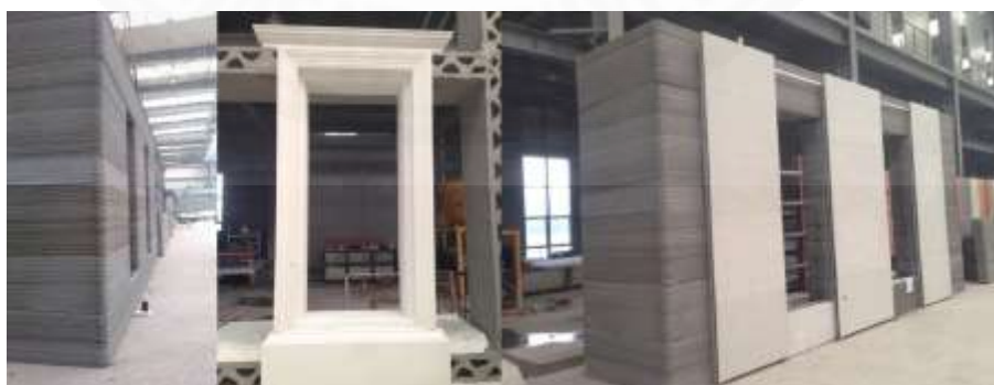
ภาพที่ ผ.18 การก่อสร้างอาคารด้วยการพิมพ์สามมิติระบบ FDM ของ WINSUN. จาก http://3dprint.com/wp-content/uploads/2015/01/b31.jpg , 2015
