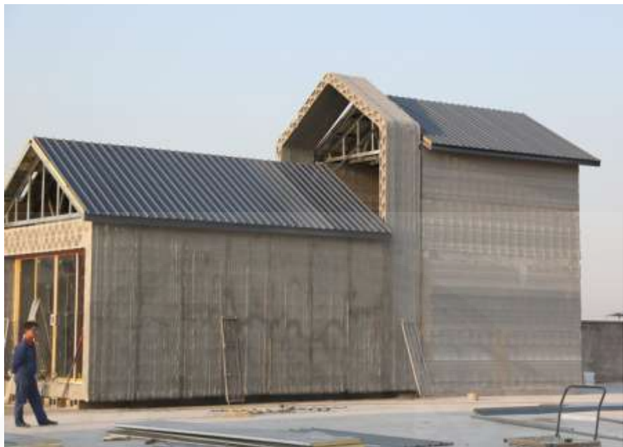
ภาพที่ ผ.19 การก่อสร้างอาคารด้วยการพิมพ์สามมิติระบบ FDM ของ WINSUN. จาก http://minionvilla.com/wp-content/uploads/2014/04/winsun-3d-printed-house-china.jpg , 2015
