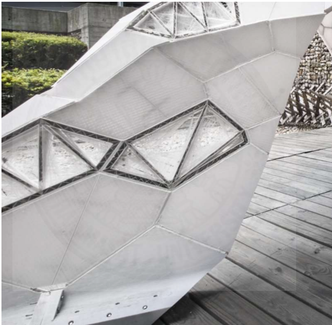
ภาพที่ 2.50 การประกอบชิ้นงานโดยมีการใส่สลักไว้ระหว่างชิ้นส่วนแต่ละชิ้น. จาก http://3dprint.com/80490/silky-concrete-project , 2015
