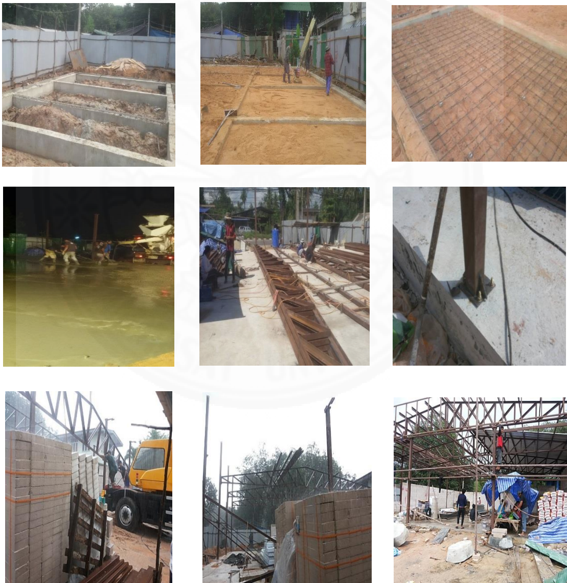
ภาพที่ 4.4 งานโครงสร้าง.
