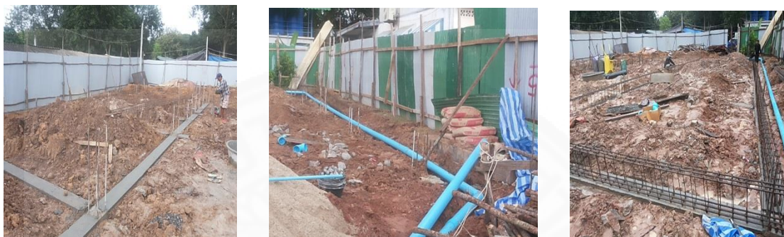
ภาพที่ 4.3 งานระบบประปาและสุขาภิบาล.
