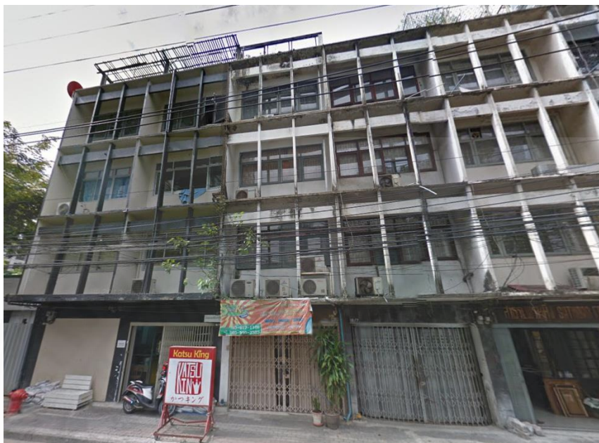
ภาพที่ 4.8แสดงรูปแบบทางสถาปัตยกรรมอาคารพาณิชย์เก๋าย่านชอยสาทร 11เขตสาทร
