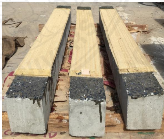
(d) Apply sisal FRP composite on tension face (bottom) of RC beam
