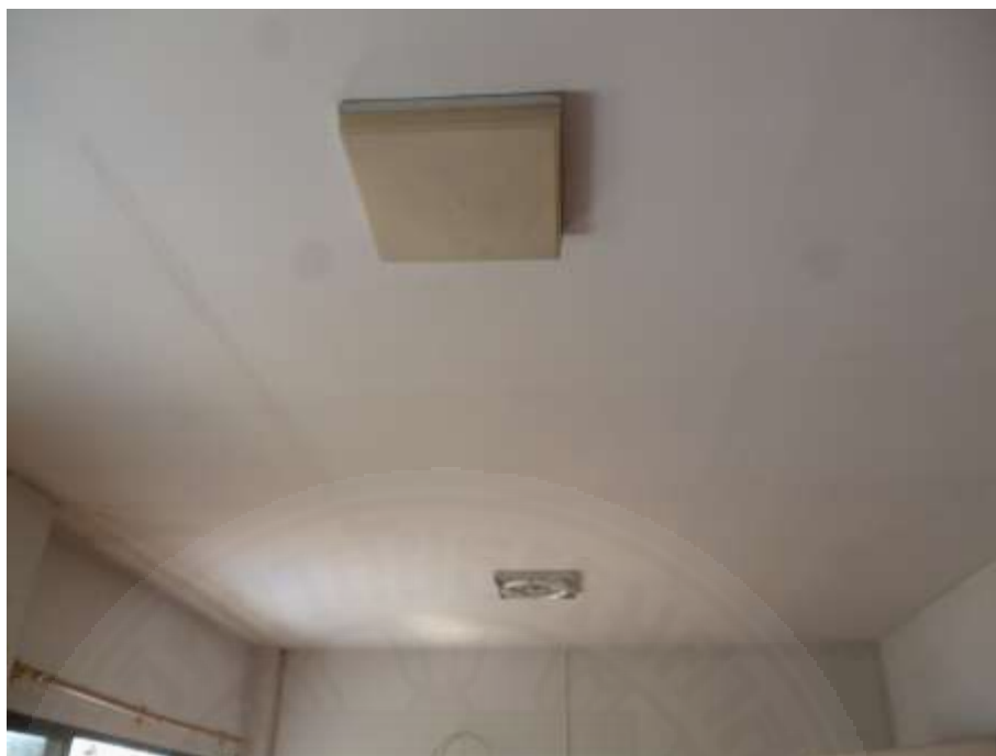
ภาพที่ 4.4 ลักษณะตัวอย่างฝ้าเพดานยิบซั่มบอร์ดแบบฉาบเรียบ
