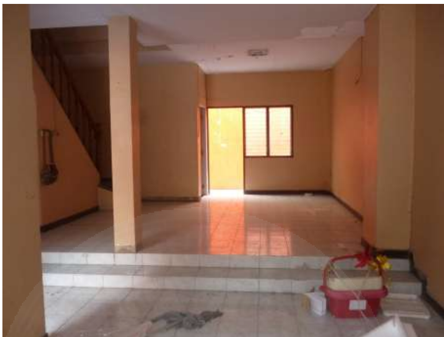
ภาพที่ 4.6 ลักษณะตัวอย่างผนังอาคารเป็นการก่ออิฐฉาบปูนทาสี
