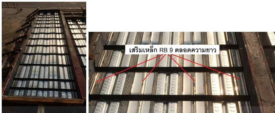
ภาพที่ 4.22 การติดตั้งอุปกรณ์ต้านแรงเฉือนสำหรับตัวอย่างทดสอบแบบที่ 7 (SFR-4m)
