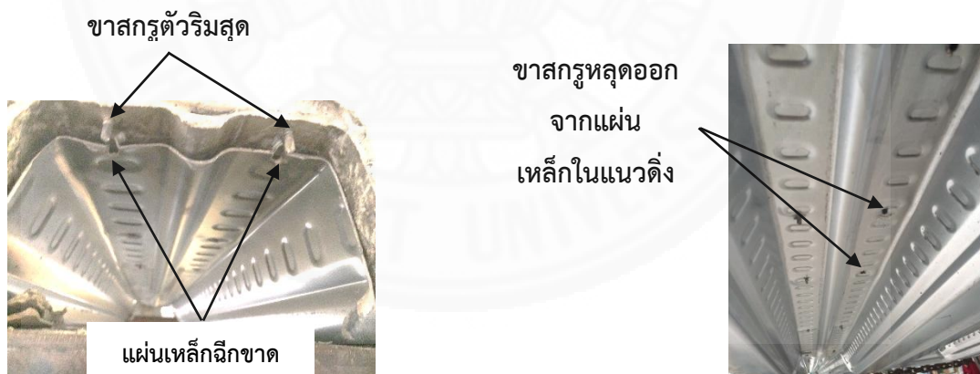
ภาพที่ 5.25 การฉีกขาดของแผ่นเหล็กที่ปลายแผ่นพื้นเนื่องจากแรงกดด้านข้าง (Beaing) ที่ขาของสกรู จนทำให้ปลายแผ่นเหล็กขาดที่ปลายของแผ่นพื้นด้านที่เกิดการวิบัติ ในตัวอย่างทดสอบแบบที่ 3 (SS-4m)
