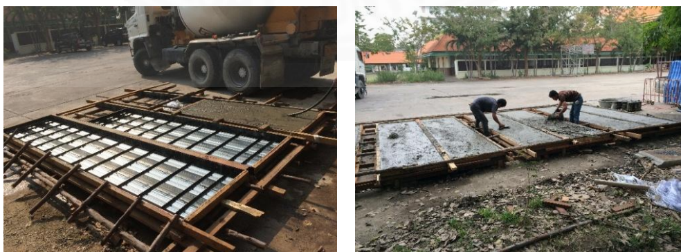
ภาพที่ 4.6 ในขณะที่เททำการจี้คอนกรีตด้วยเครื่องสั่นเพื่อไล่ฟองอากาศ จากนั้นทำการแต่งระดับ หน้าคอนกรีตให้เสมอกันทั่วทั้งแผ่นพื้น
