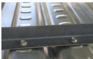
ภาพที่ 4.11 ลักษณะการยึดเหล็กฉากกับแผ่นเหล็กกรีดลอนโดยใช้สกรู 2 ตัวต่อ 1 ลอน
