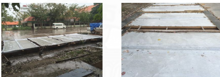
ภาพที่ 4.7 การบ่มคอนกรีตโดยใช้วิธีห่อพลาสติก
