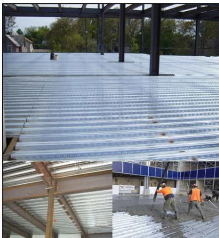
ภาพที่ 1.2 การติดตั้งแผ่นพื้นคอมโพสิต : ภาพจาก Development Industry Joint Stock Corporation
