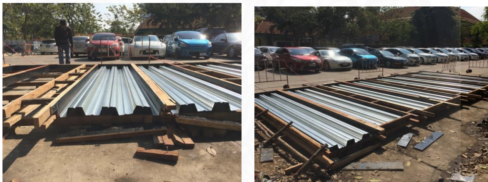
ภาพที่ 4.5 การเข้าแบบแผ่นพื้น
