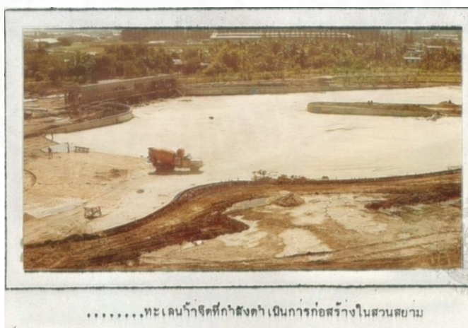
ภาพที่ 4.2 ทะเลน้ำจืดที่กำลังดำเนินการก่อสร้างในสวนสยาม
