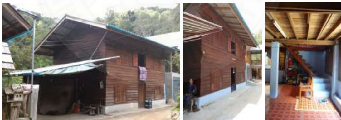
ภาพที่ ก.6 การปรับปรุงพื้นบ้านชั้นล่างของบ้านไม้สองชั้นเป็นพื้นเทคอนกรีต (TH-H9).
