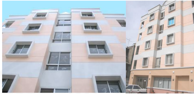
ภาพที่ 2.54 ตัวอย่างอาคารพักอาศัย 5 ชั้น จำนวน 60 ห้อง. www.smilehomes.com
