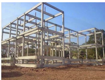
ภาพที่ 2.39 ระบบก่อสร้างแบบเสาคาน. www.sumrerng , 2014.
