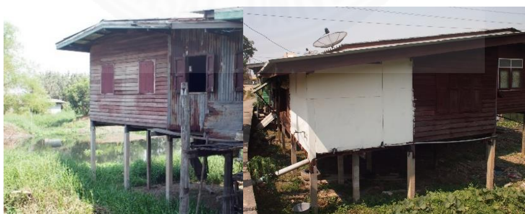
ภาพที่ 4.35 เสาคอนกรีตบริเวณใต้ถุนบ้าน. โดยผู้วิจัย
