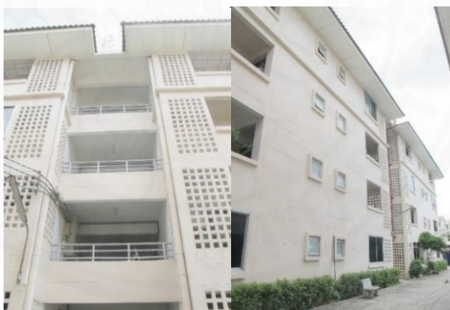
ภาพที่ 4.74 อาคารชุมชนวัดพระยาไกรด้านหน้าอาคาร (ซ้าย) ด้านข้างของอาคาร (ขวา). โดยผู้วิจัย 8 กรกฎาคม 2558
