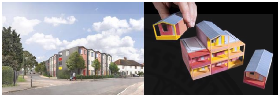
ภาพที่ 2.65 Y Cube London. Photo by Courtesy of New London Architecture, 2014
