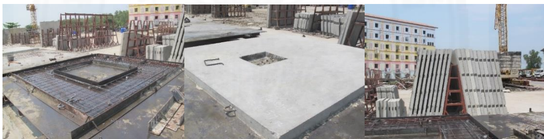
ภาพที่ 4.54 แม่พิมพ์ของแผ่นคอนกรีตสำเร็จรูป (ซ้าย) แผ่นคอนกรีตสำเร็จรูป (กลาง) แผ่นคอนกรีตสำเร็จรูปที่เตรียมขนย้าย (ขวา) . บริษัท ชัมมิท โพนเฮอร์สท กอล์ฟ คลับ จำกัด
