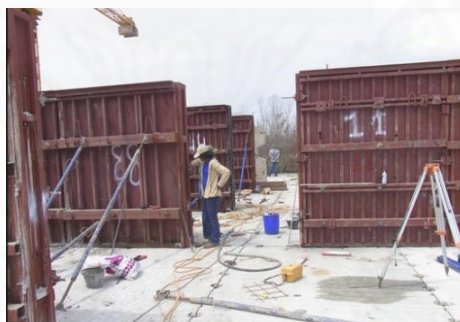
ภาพที่ 2.38 การใช้ โครงเหล็ก Alpha Truss หอพัก C1 กอล์ฟฟิว. บริษัท ชัมมิท ไพน์เฮิร์สท กอล์ฟคลับ จำกัด, 2558
