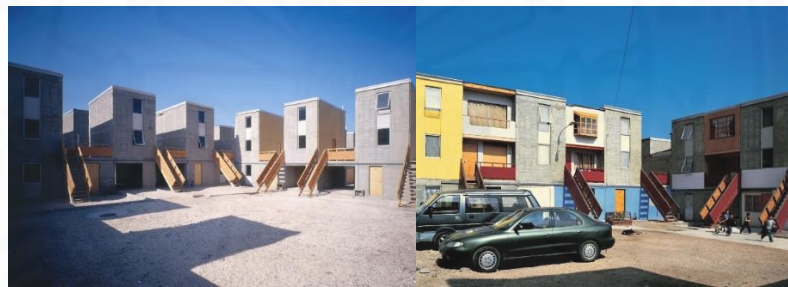
ภาพที่ 2.57 เปรียบเทียบก่อนการอยู่อาศัยและหลังเข้าอยู่อาศัยของอาคาร. Elemental, 2003
