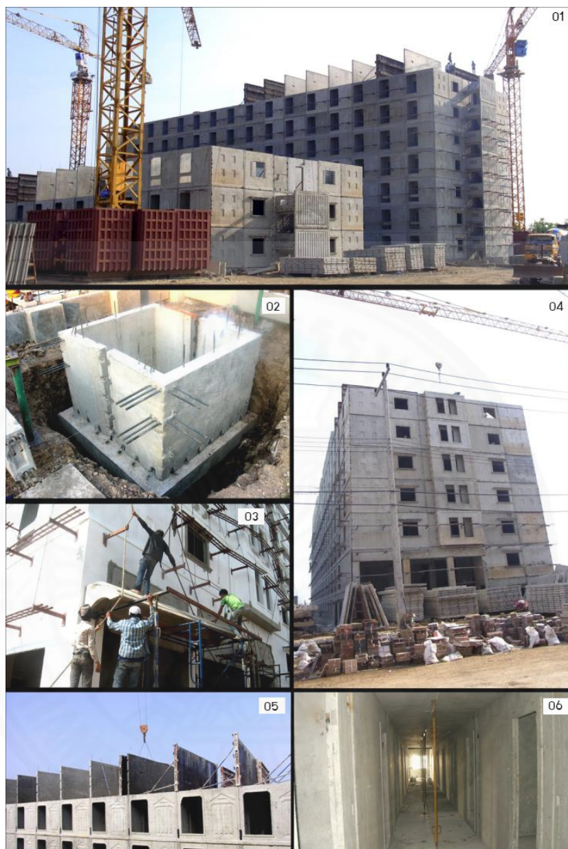
ภาพที่ 4.58 งานก่อสร้างและโครงสร้างอาคารC1กอล์ฟวิว. บริษัทซัมมิทไพน์เฮิร์สทกอล์ฟ คลับจำกัด
