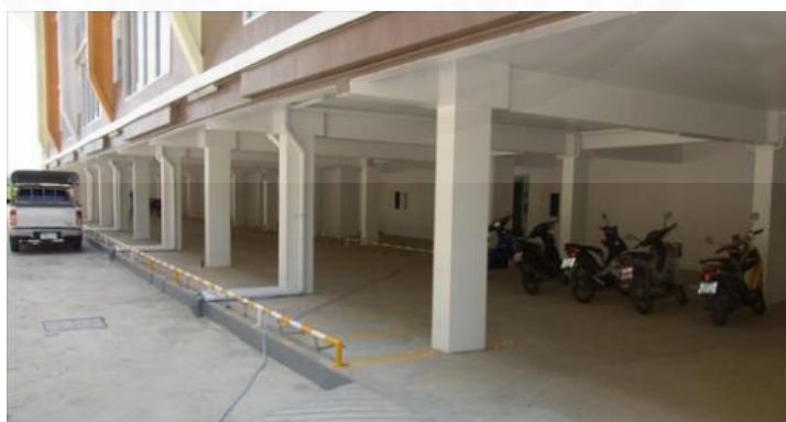
ภาพที่ 4.66 พื้นทีสำหรับที่จอดรถใต้อาคาร. บริษัท ชัมมิท โพน์เฮิร์สท กอล์ฟ คลับ จำกัด
