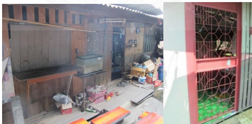
ภาพที่ 4.37 ช่องเปิดระบายอากาศ (ซ้าย) และลูกกรงเหล็กดัดประตู (ขวา) . โดยผู้วิจัย
