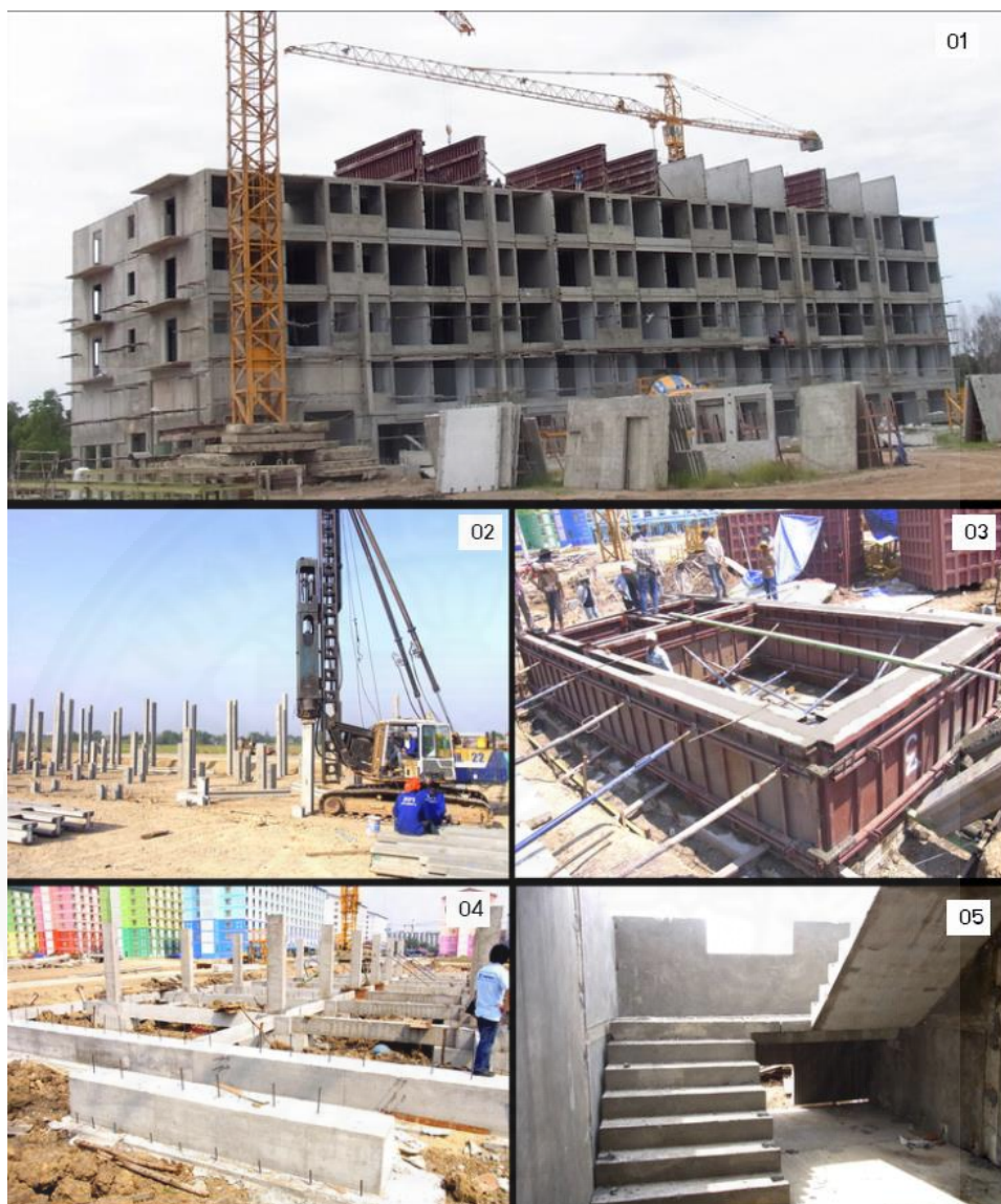
ภาพที่ 4.63 งานก่อสร้างและโครงสร้างอาคารหอพัก Golf Paradise กอล์ฟพิว. บริษัท ชัมมิท ไพน์ เอิร์สท กอล์ฟ คลับ จำกัด
