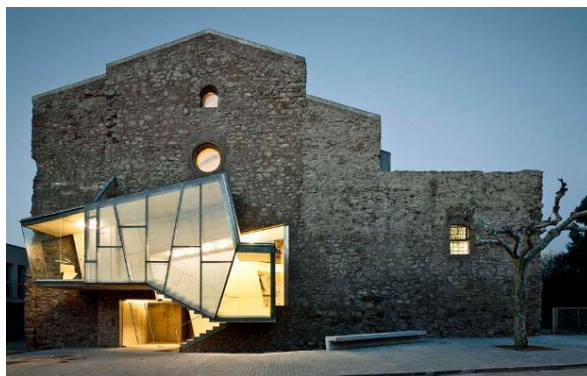
ภาพที่ 2.163 ด้านหน้าอาคาร Church of Sant Francesc Convent, โดย archdaily, 2012
