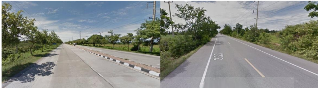
ภาพที่ 5.5 ทางหลวงหมายเลข 321 และ ภาพที่ 5.6 ทางหลวงหมายเลข 333 ,จาก google street view
