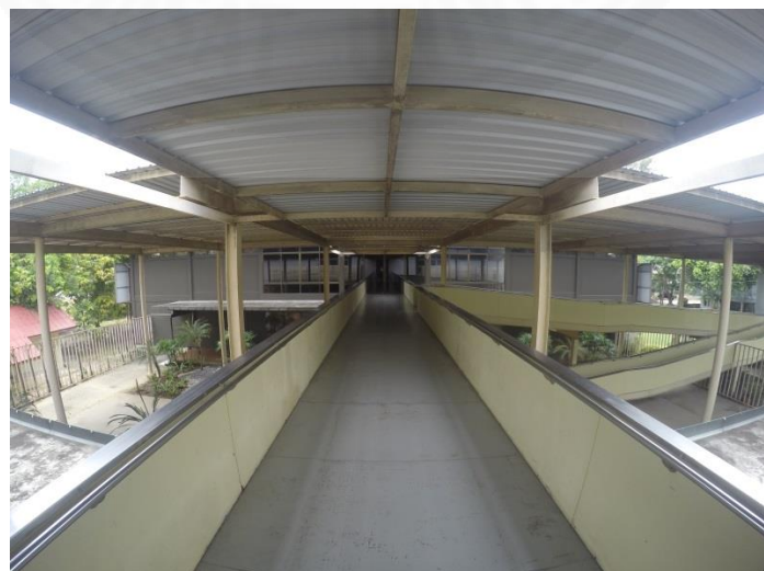
ภาพที่ 5.25 ทางเชื่อมอาคารจัดแสดงชั้น, โดย ผู้วิจัย
