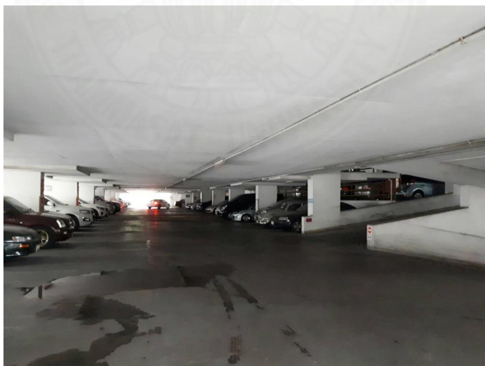
ภาพที่ 1.3 ภายในอาคารจอดรถ
