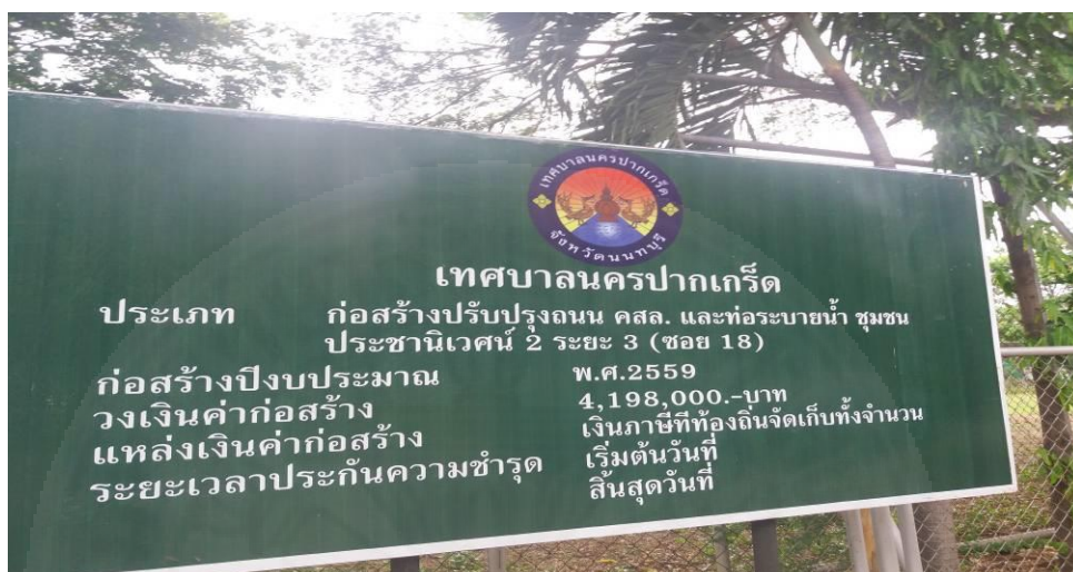
ภาพที่ 3.10 ชุมชนได้รับการสนับสนุนจากเทศบาลนครปากเกร็ดในการก่อสร้างถนน คสล. และระบบระบายน้ำในชุมชนประชาชนเวิศน์ 2 ระยะ 3
