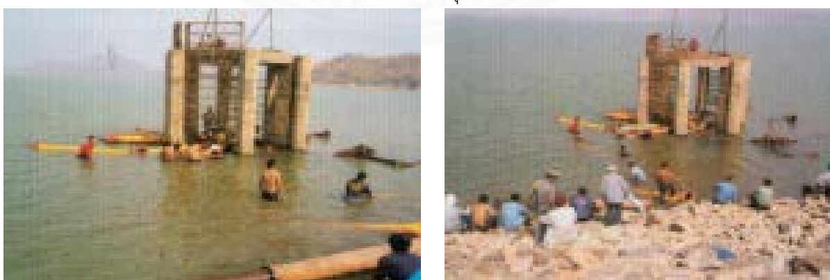
ภาพที่ 3.15 การร่วมกันติดตั้งท่อกาลักน้ำของกลุ่มผู้ใช้น้ำ, ที่มา : กองส่งเสริมการมีส่วนร่วมของประชาชน กรมชลประทาน
