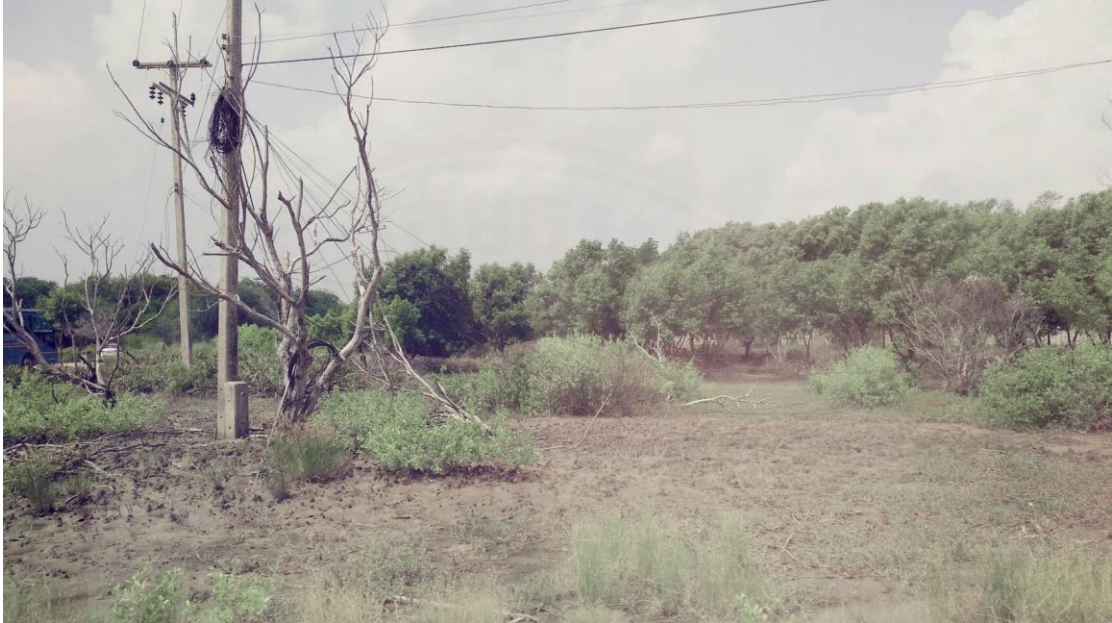
ภาพโดยรอบโครงการบ่อบำบัดน้ำเสียคลองด่าน
