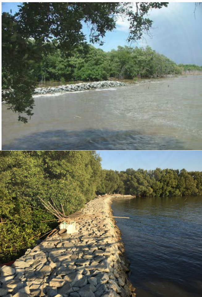
ภาพที่ 4.4 แนวโครงสร้างหินทิ้งป้องกันน้ำทะเลกัดเซาะ บริเวณชายฝั่งทะเลบ้านคลองด่าน หมู่ที่ 8
