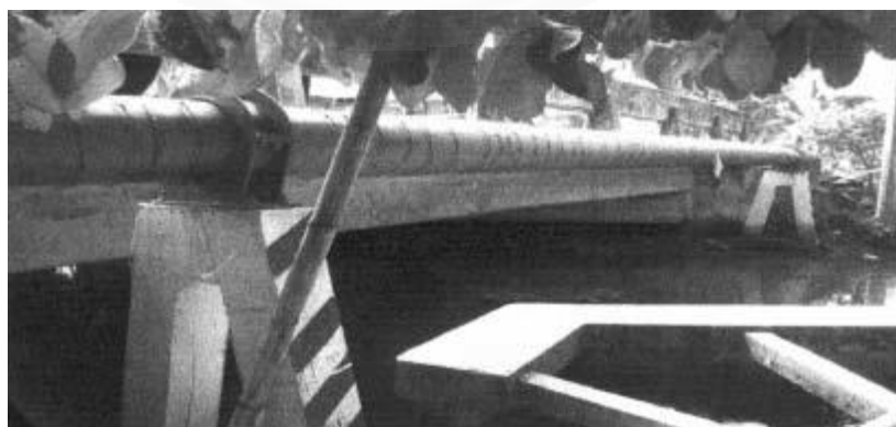
ภาพที่ 2.8 การวางท่อไปกับสะพาน, กรมเจ้าท่า, คู่มือการอนุญาตให้ปลูกสิ่งปลูกสร้างล่องลำลำนน้ำและการขุดลอกร่องน้ำขนาดเล็ก, พิมพ์ครั้งที่ 4 (กรุงเทพฯ: กรมเจ้าท่า, 2554), 2.
