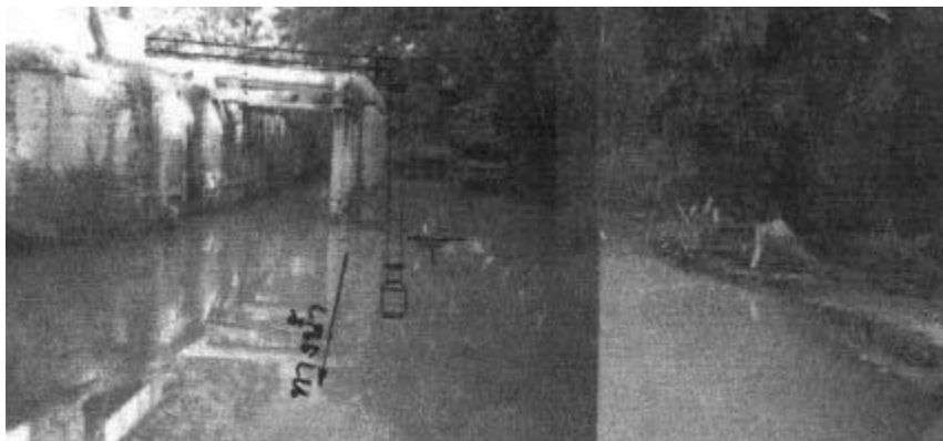
ภาพที่ 2.10 โรงสูบน้ำ, กรมเจ้าท่า, คู่มือการอนุญาตให้ปลูกสิ่งปลูกสร้างล่งล้าลำน้ำและการขุดลอกร่องน้ำขนาดเล็ก, พิมพ์ครั้งที่ 4 (กรุงเทพฯ: กรมเจ้าท่า, 2554), 1.
