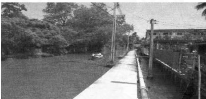
ภาพที่ 2.7 การวางท่อและการปักเสาไฟฟ้าในน้ำ, กรมเจ้าท่า, คู่มือการอนุญาตให้ปลูกสิ่งปลูกสร้างล่องลำลำนน้ำและการขุดลอกร่องน้ำขนาดเล็ก, พิมพ์ครั้งที่ 4 (กรุงเทพฯ: กรมเจ้าท่า, 2554), 2.
