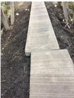
ภาพที่ 4.10 แผ่นพื้นที่ไม่เสมอกัน
